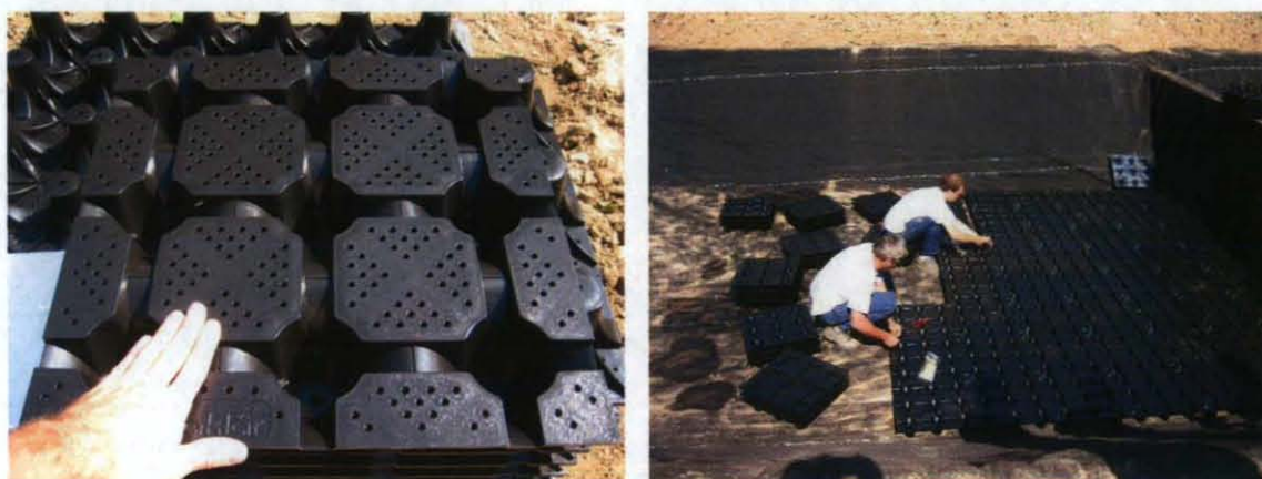
Figure 3 : photos du plancher aérant Biobloc®
