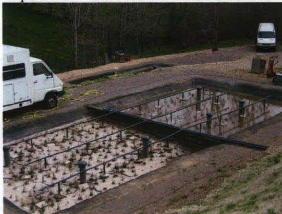
Figure 1 : Ramps d'alimentation du premier étage de traitement. Burdignes le 24/04/2006
