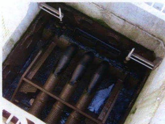
Figure 5 : Photo des drains non saturés après arrêt du fonctionnement du siphon
