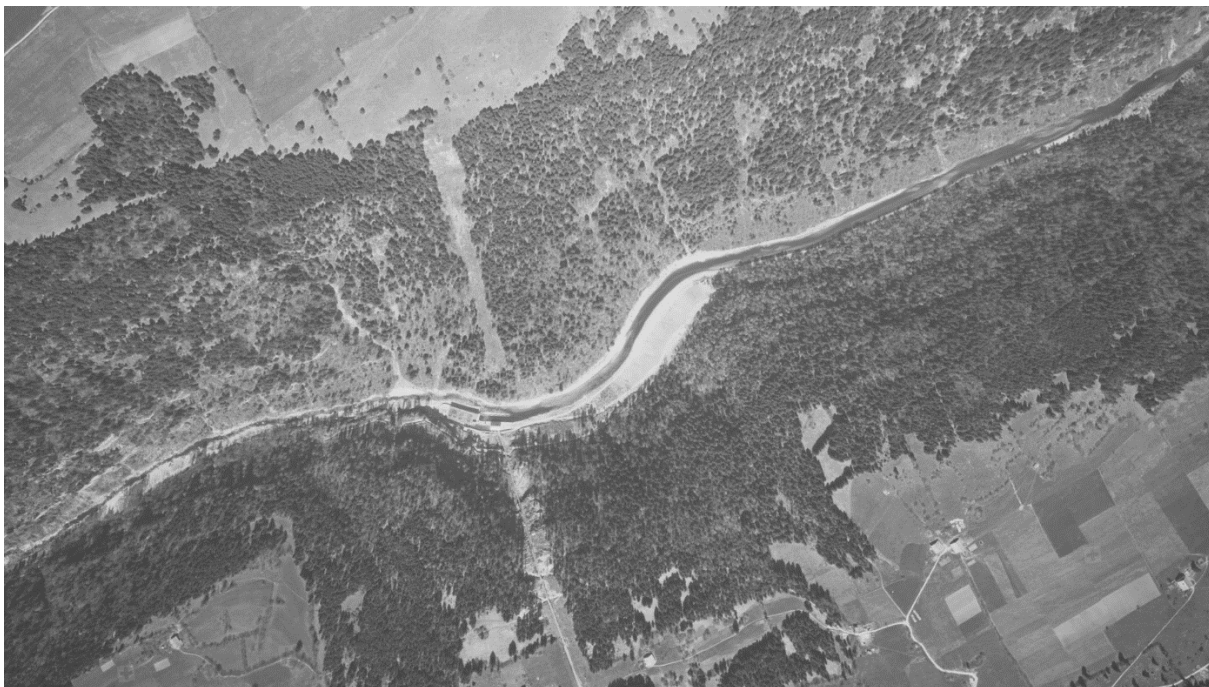
Figure 6.1 : Illustration des travaux d'installation de l'usine du Châtelot en 1953 ayant provoqué le passage au bull et le surcreusement d'une partie du linéaire du Doubs.(image swisstopo 1956)
