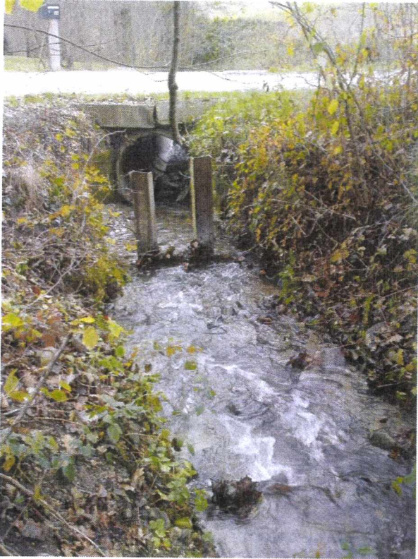
Photo 13 : Pieux mis en protection du busage (Chez Rossillon)
