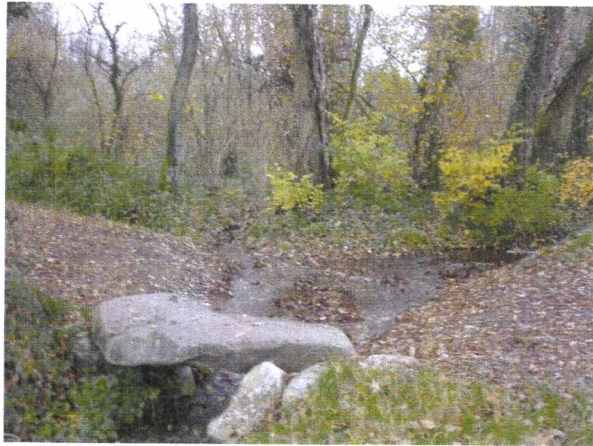
Photo 7 : L'écoulement s'effectue avec une pente faible, le lit est donc envasé
