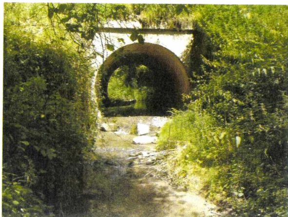
Photo 12 : Pont de la RD 251
