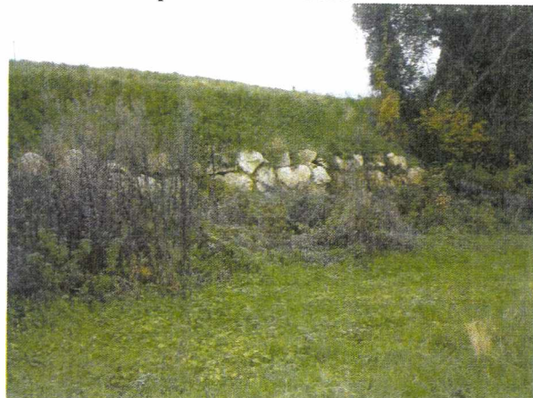
Photo 7 : Quelques enrochements en soutènement d'une voirie à proximité de la source
