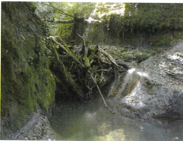
Photo 3 : Bouchon au niveau de la confluence du ruisseau de Bartave
