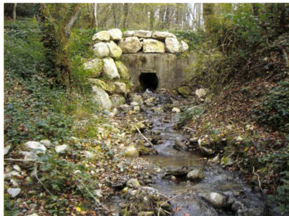
Photo 26 : ouvrage du CR de Veronnex
