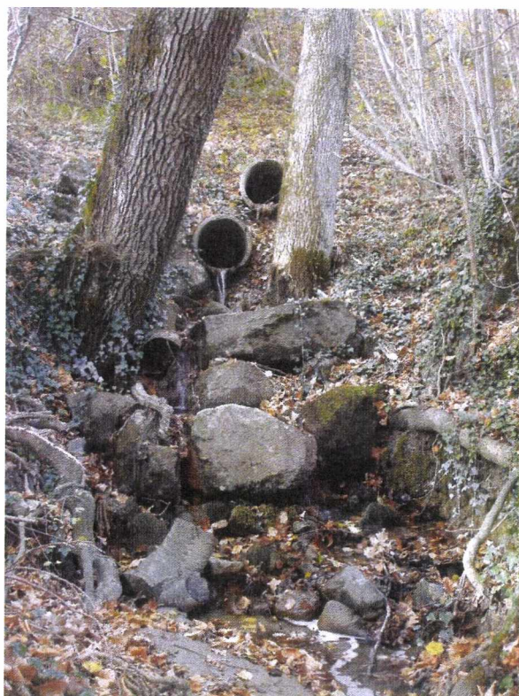
Photo 1 : Tronçon busé créé suite à la rectification du tracé de la route
