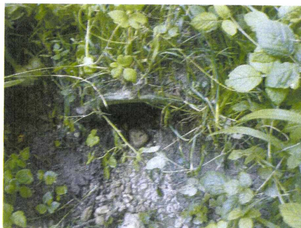
Photo 11 : Buse obturée, l'eau peut s'écouler par surverse sur le chemin
