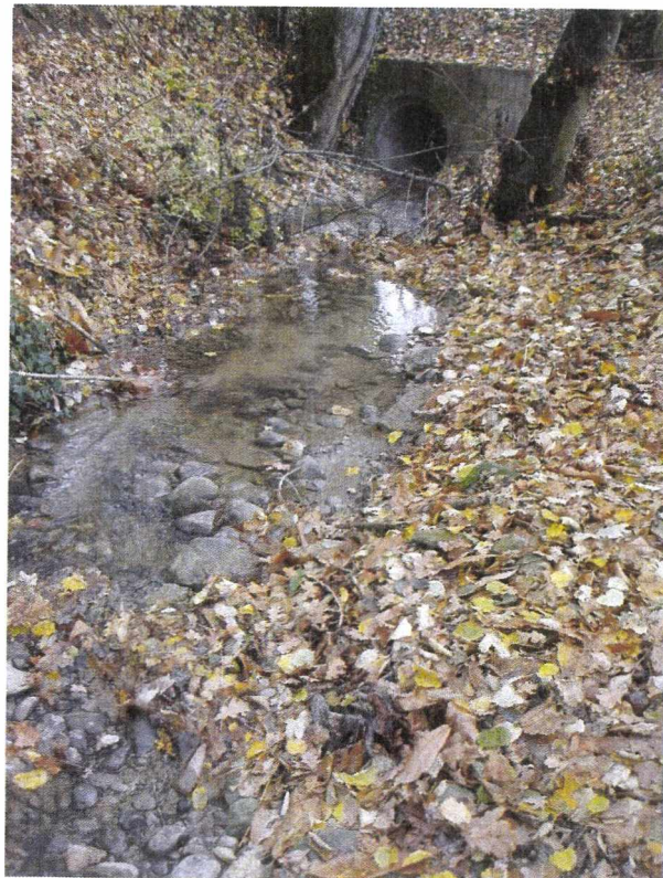
Photo 9 : Les ouvrages de franchissement sur le ruisseau sont tous en bon état.
