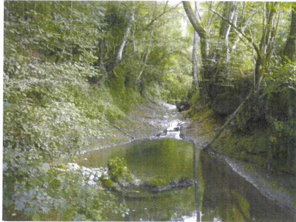
Photo 3 : Seuil en pierre maçonné, probable vestige d'un ouvrage plus important (plan d'eau ?) destiné à retenir l'eau en période sèche.
