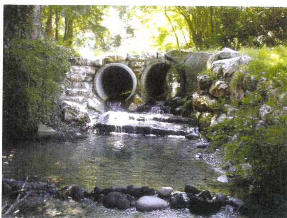
Photo 16 : Deuxième ouvrage de franchissement en amont du moulin. Celui-ci a déjà été fortement endommagé en période de crue. De plus, on observe une érosion régressive à l'aval de l'ouvrage, provoquée par l'accélération de l'écoulement
