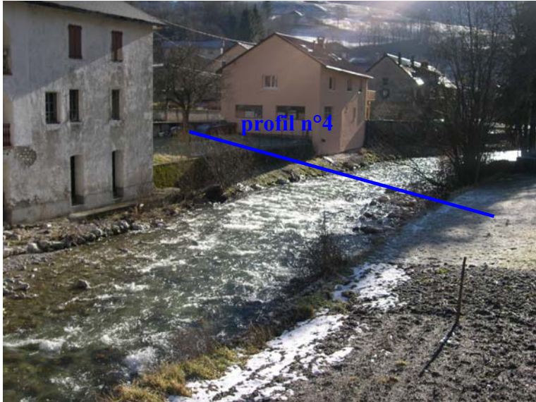
Photo n°16 : localisation du profil en travers n°4 en aval du pont
