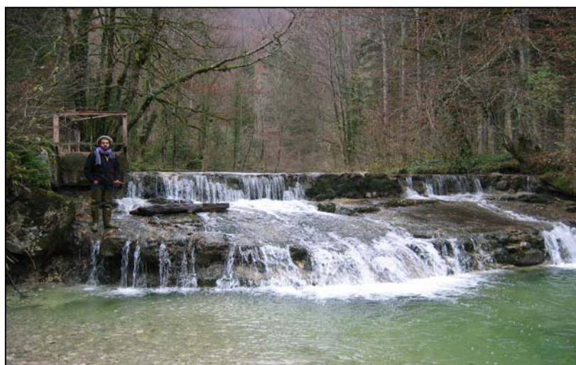
Seuil au lieu dit « Moulin Neuf »
