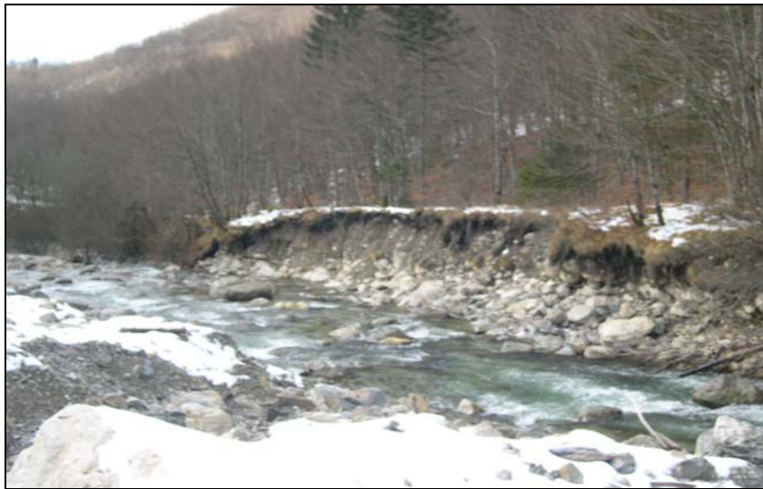
Photo n° 14 : Sapement de berge à l'aval de la confluence avec La Rivière
