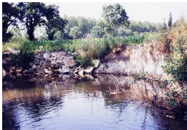
Planche photo 5 : berge à base caillouteuse dont une partie de la protection a été détruite.
