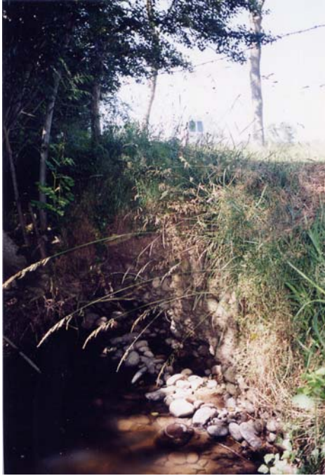
Le Vieux Jonc en amont de « Curtablanc »
