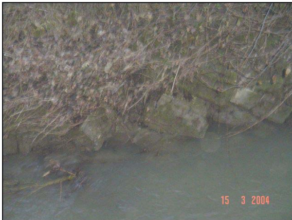
Photo 5 : vue des protections de berges en rive droite (parpaings, blocs, tout venant)
