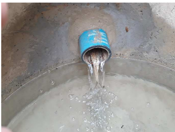
drain côté Ouest
