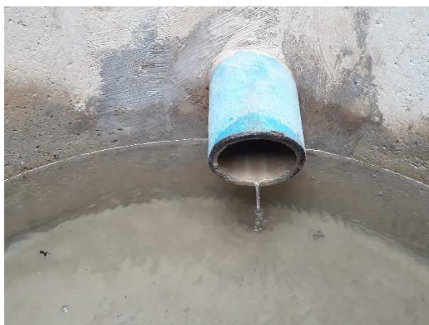
drain côté Est
