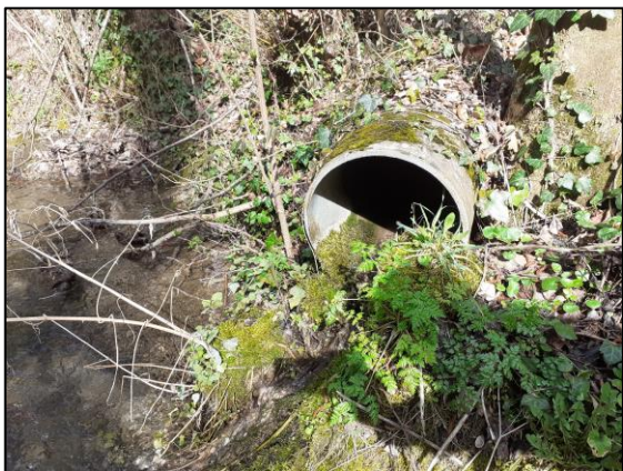
Exutoire du réseau unitaire
