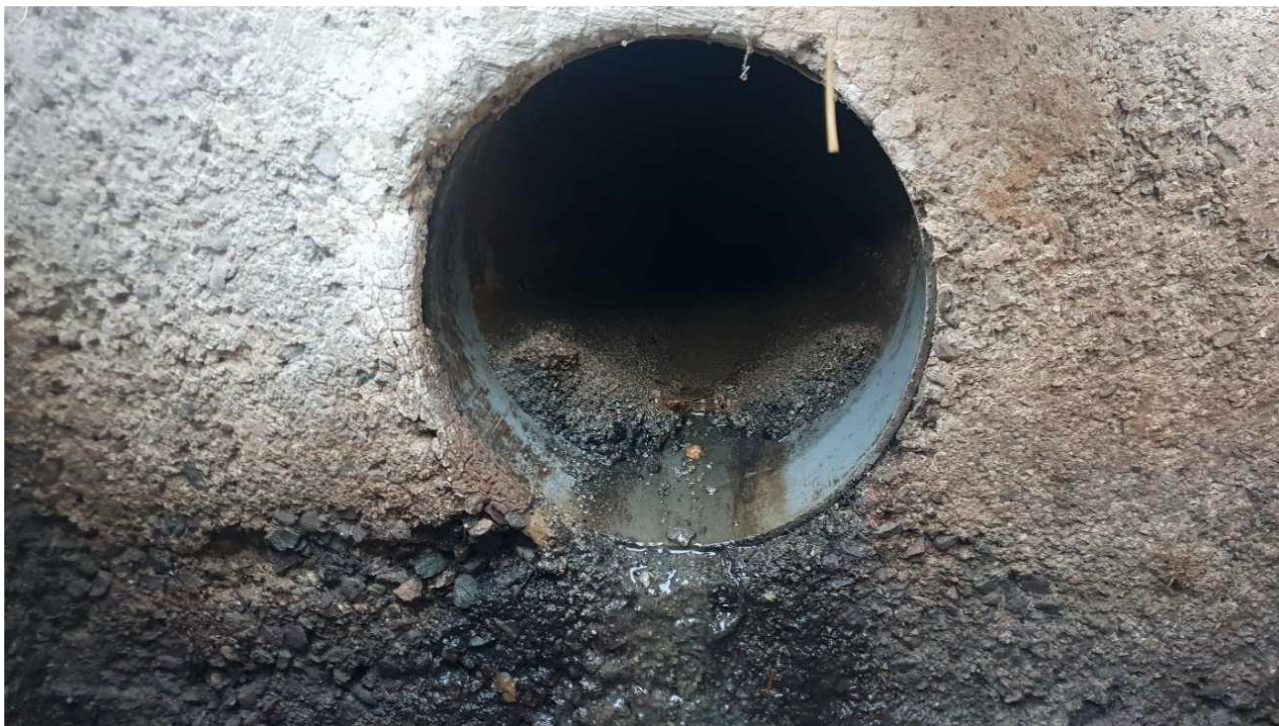
Figure 1 : Dépôt de sable et de gravier observé à la fin de la campagne de mesures
