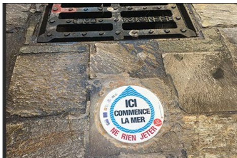
Exemple de nudge installé en Bretagne « la mer commence ici »
