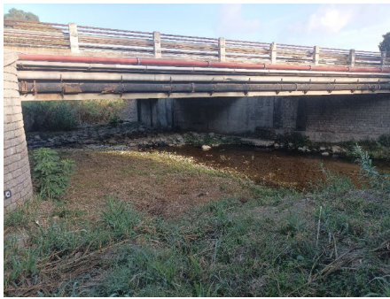
Ouvrage sur le Bevinco à risque embâcles faibles et enjeux faibles demandant un entretien tous les 5 ans
