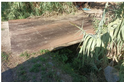
Visite d'un ouvrage de franchissement sur Les Collines – fréquence 6 mois
