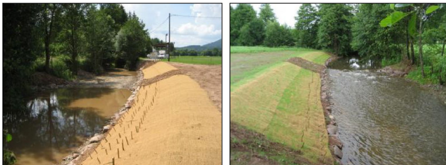
Photos de retalutage et plantation de type R2 sur la Fave (Fabien Kamber)
