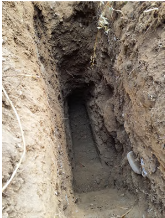
Arrêt fouille à 2.4m
