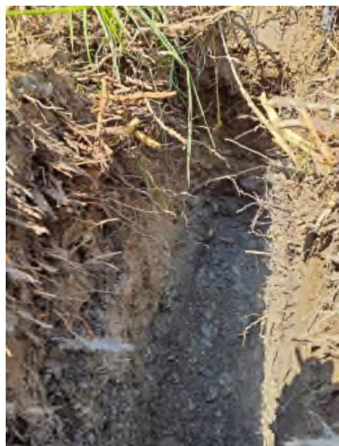
Refus pelle à 1.35m sur poudingue ou béton
