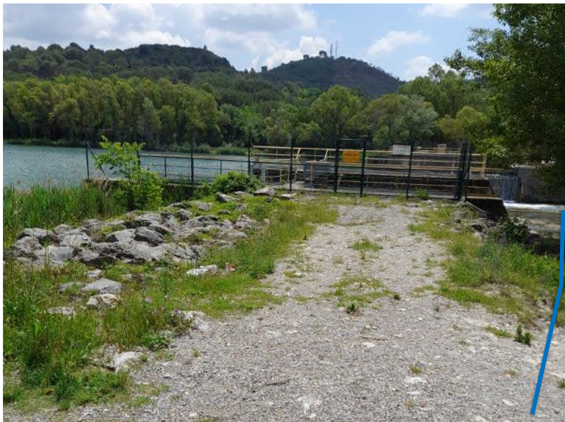
Photo n°3 : Vue du tracé au niveau de l'enracinement du seuil en rive droite
