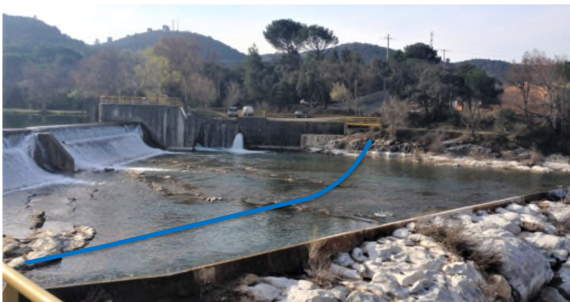
Photo n°4 : Vue du tracé au niveau du seuil et de la zone de raccordement au Canal de Noirel en rive gauche
