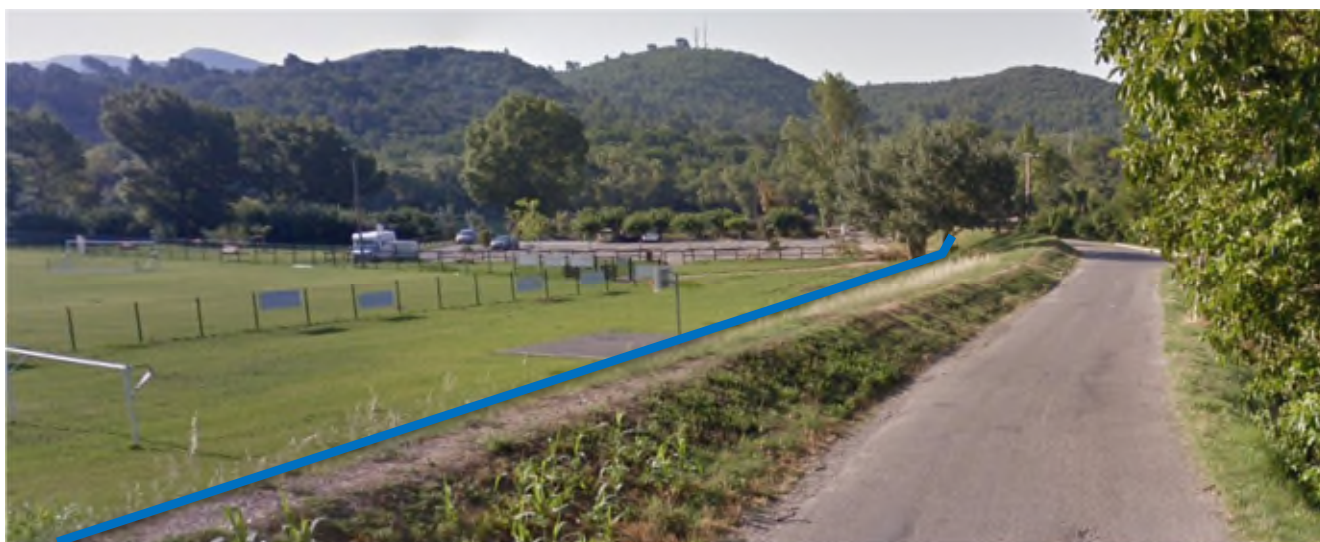
Photo n°2 : Vue du tracé de la future conduite enterrée le long de la rue Font Vieille
