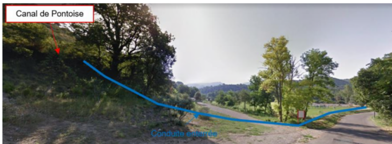
Photo n°1 : Vue du tracé de la future conduite enterrée du canal de Pontoise à la rue Font Vieille
