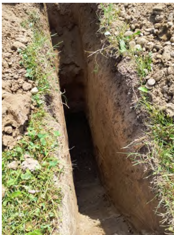
Arrêt fouille à 2.3m
