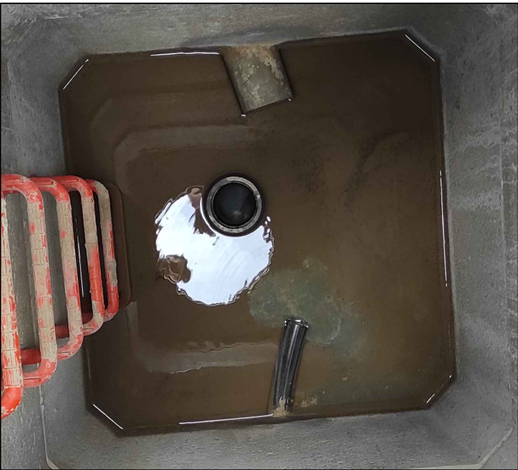
Ouvrage du drain Gauche
