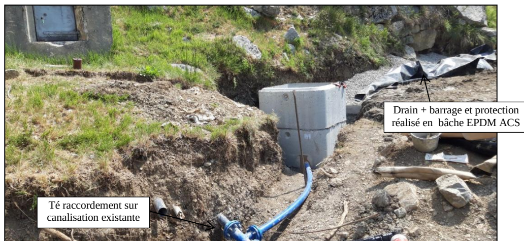
Travaux de création de l'ouvrage de captage récent (02/08/2022)
