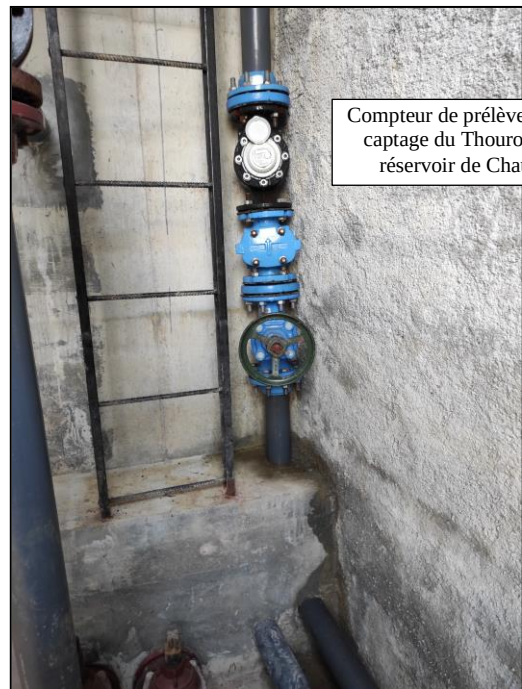
Illustration des compteurs de prélèvements de La Rochette et du Thouron
