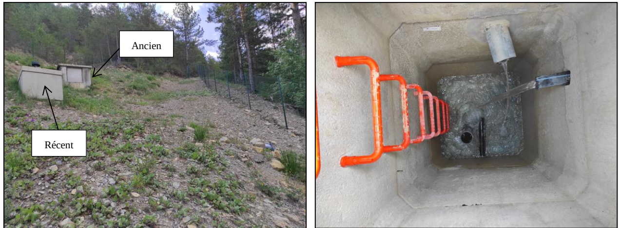
Ouvrage de drain droit « récent » des captages de la Rochette (13/07/2022)
