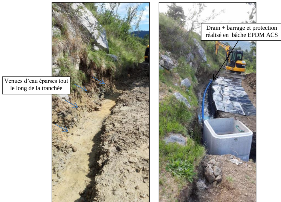
Travaux de création de l'ouvrage de captage récent (02/08/2022)
