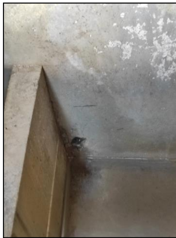
Arrivée d'eau dans le bac de départ (13/07/2022)
