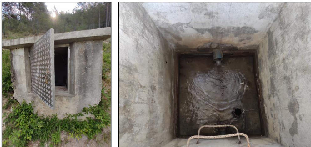
Ouvrage de drain droit « ancien » des captages de la Rochette (13/07/2022)
