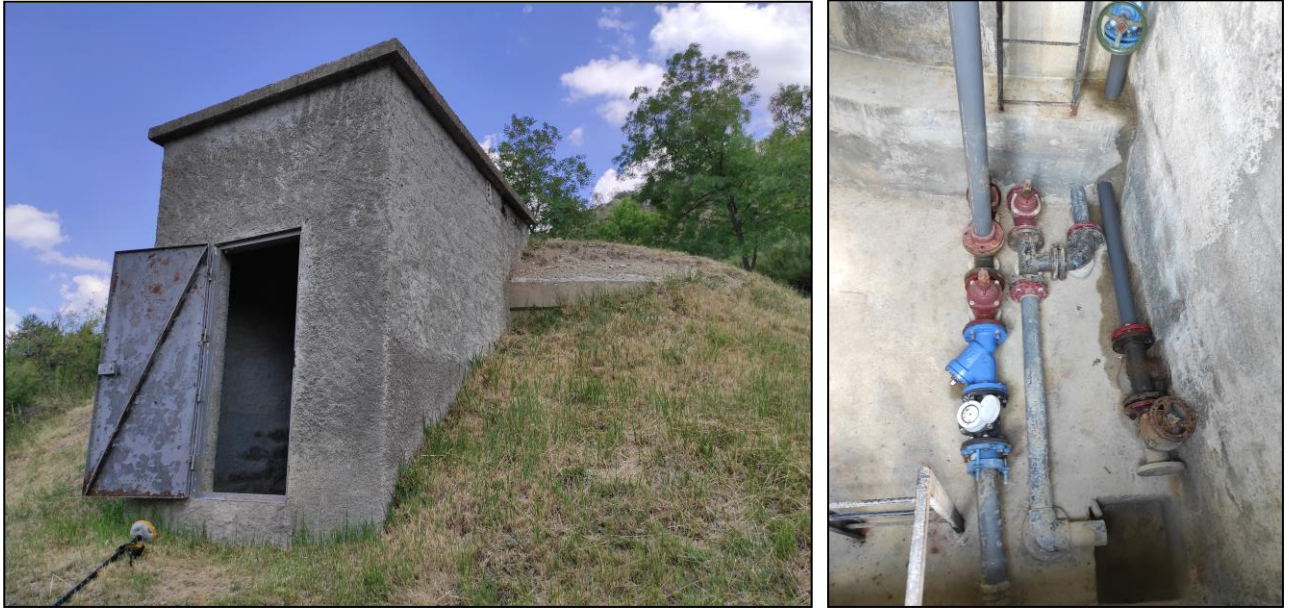
Réservoir de Chaudon (13/07/2022)
