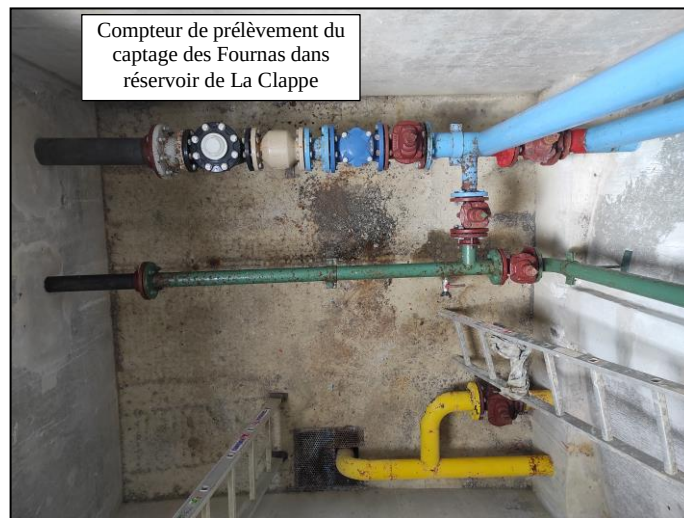
Illustration du compteur de prélèvement des Fournas
