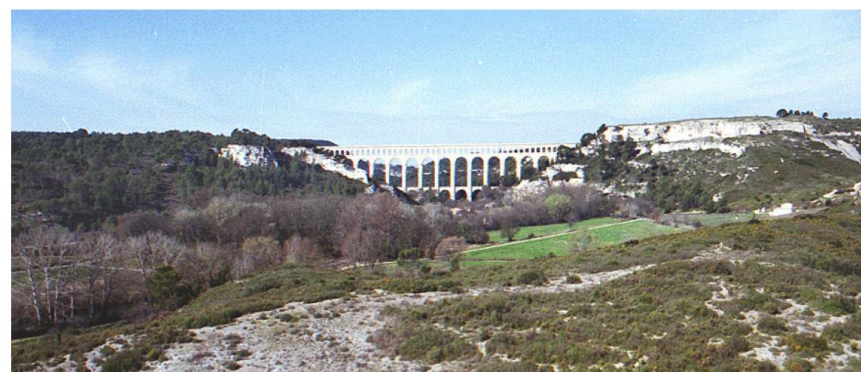
49 - Ventabren. L'aqueduc de Roquefavour enjambe de façon spectaculaire et « à la romaine » la vallée de l'Arc entre les plateaux de Ventabren et du Grand Arbois
