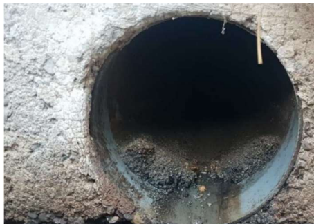
Figure 1 : Dépôt de sable et de gravier observé à la fin de la campagne de mesures
