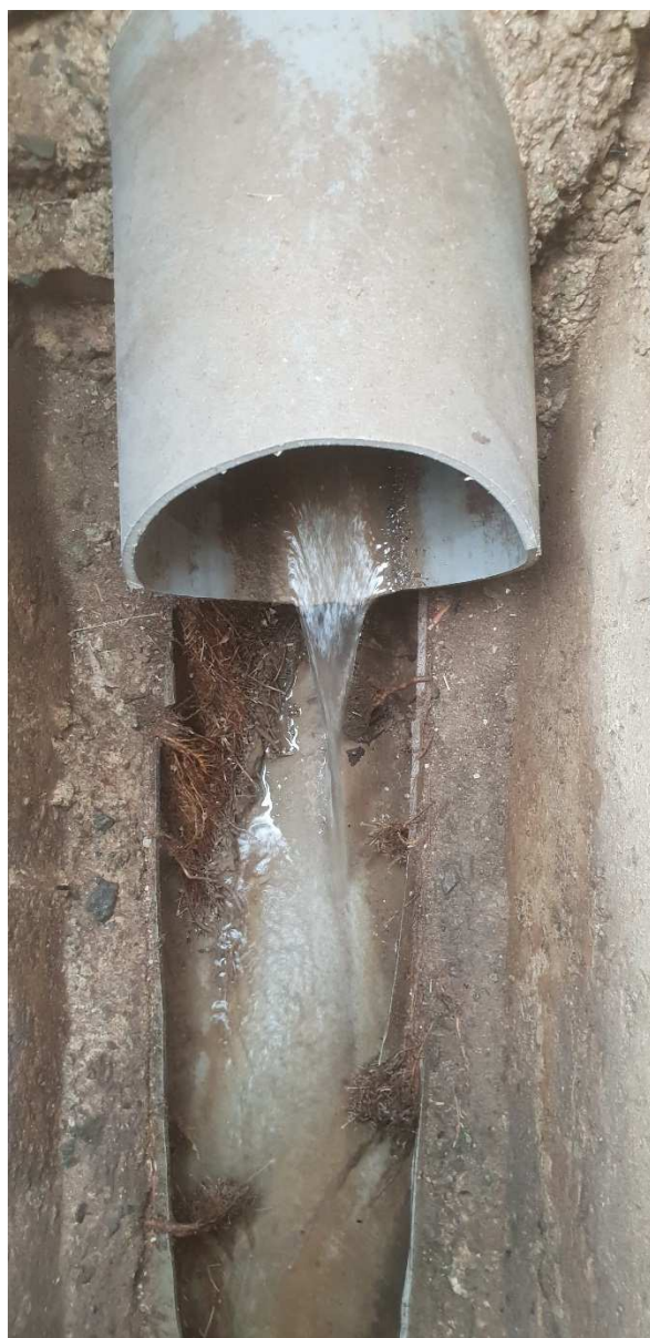
Ecoulement avant pose du matériel
