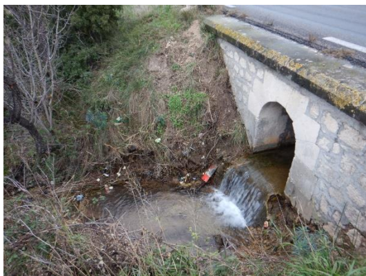
Illustration 20 Photo de la sortie aval de l'ouvrage sous la RD10 (Source : relevé setec en 2020)
