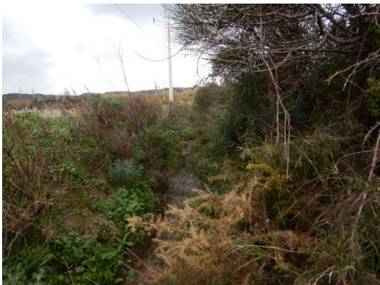
Écoulement en aval de l'ouvrage (vue vers l'amont)
