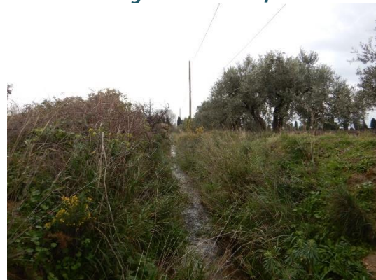
Écoulement en aval de l'ouvrage (vue vers l'aval)
