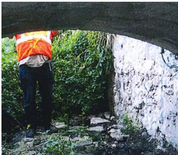
Illustration 12 entrée amont du cours d'eau en 2011 (source : PV d'inspection par l'infirpôle PACA de SNCF du 30 juin 2011)
