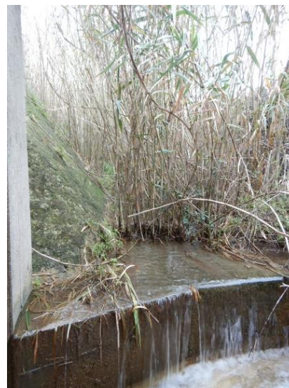
Illustration 15 en 2020, muret en béton armé sur le fossé latéral d'assainissement se déversant en rive droite à l'amont de l'ouvrage sous voie ferrée (source : setec février 2020)
