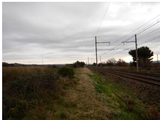
Voie ferrée en profil rasant longée par un caniveau en U (à 200 m à l'ouest de l'ouvrage)
