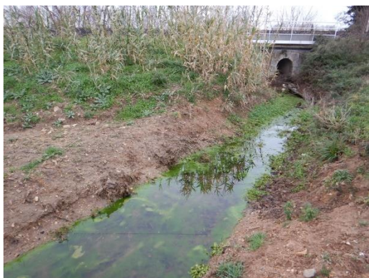
Ouvrage hydraulique sous la voie ferrée à 800m à l'est (au gauche, non visible : passage agricole)
