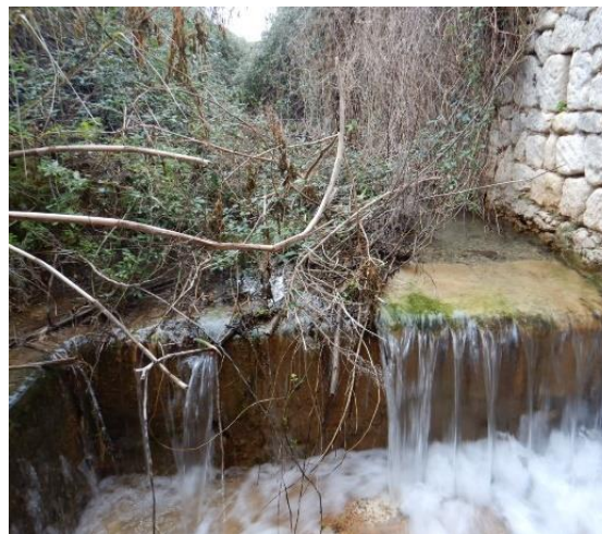
Illustration 13 entrée amont du cours d'eau en 2020 avec muret en pierre de 60 cm de haut visible (source : setec février 2020)
