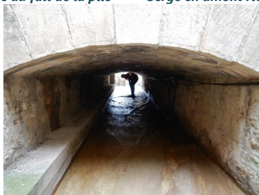
Longrine en rive droite (côté Paris) dans l'ouvrage (vue vers l'amont)
