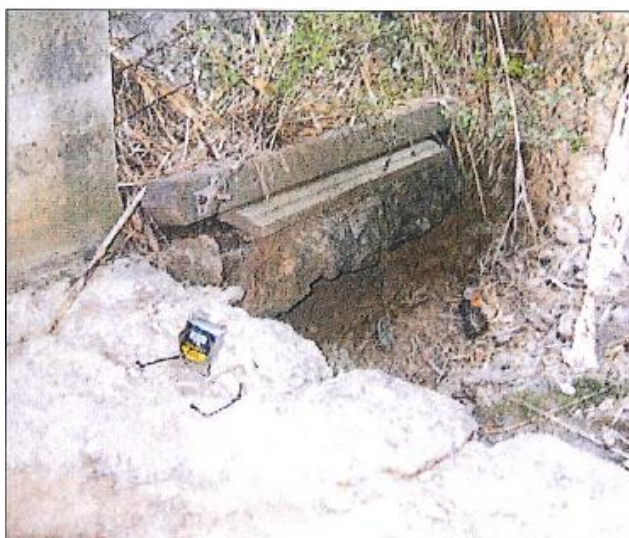
Illustration 14 vue en 2011 de la sortie du fossé latéral d'assainissement se déversant en rive droite du cours d'eau à l'amont de l'ouvrage (source : PV d'inspection par l'infirpôle PACA de SNCF du 30 juin 2011)
