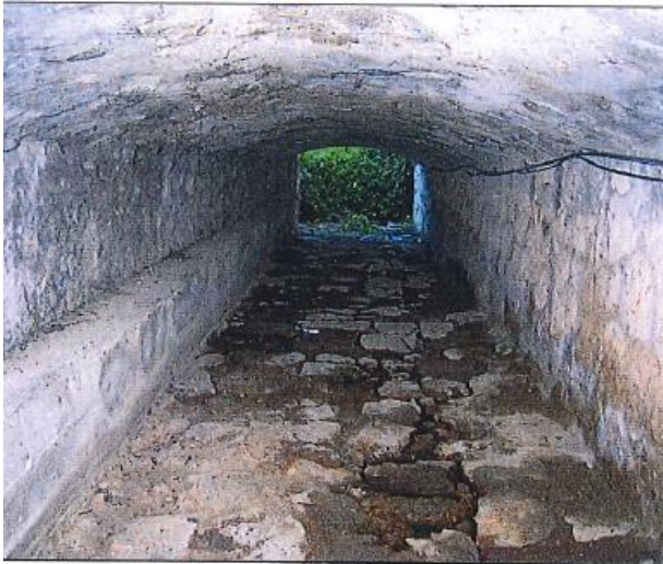
Illustration 9 photos du radier maçonné en 2011 (source : PV d'inspection par l'infrapôle PACA de SNCF du 30 juin 2011)
