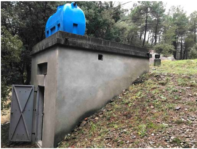
Réservoir de Malarce (cliché IATE du 20/12/2022)
