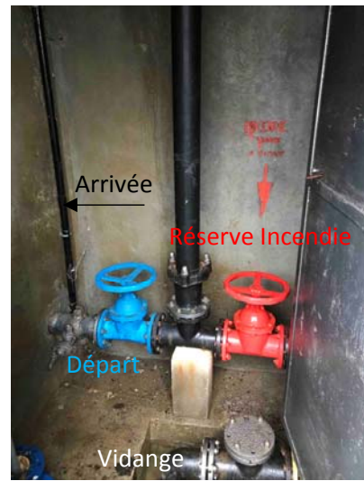
Chambre des vannes
