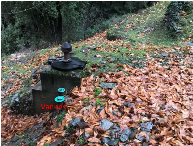
Réservoir de Malarce Mairie (cliché IATE du 20/12/2022)
