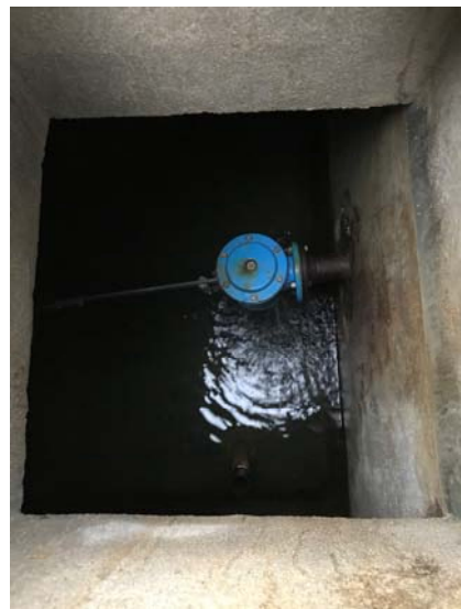
Robinet flotteur sur l'arrivée
