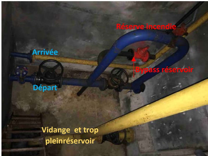
Chambre des vannes
