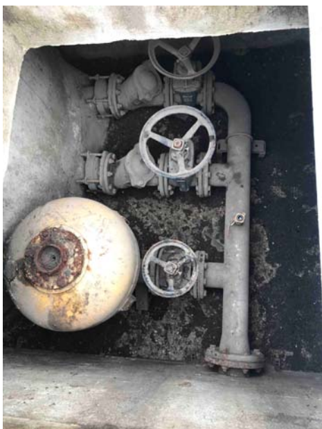
Chambre de vannes
