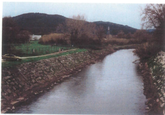
Le Gapeau, vue vers l'amont depuis le pont de l'ancienne RN 98 au droit du collège Marcel Rivière
