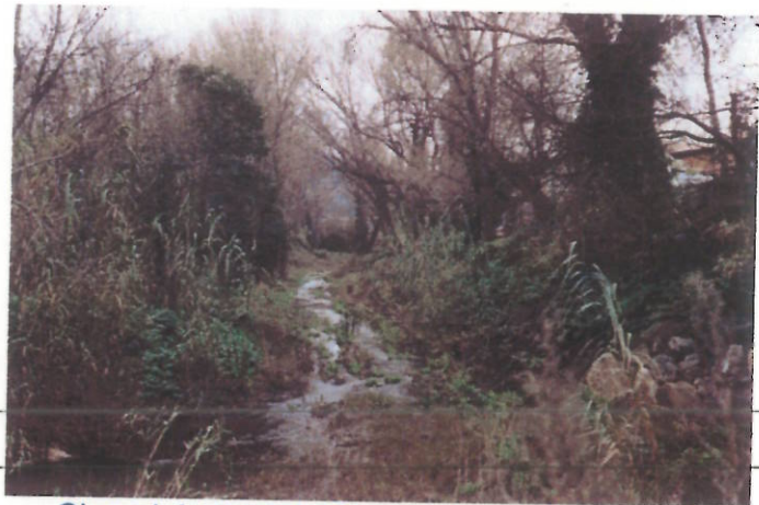
Chenal de crue du Gapeau immédiatement à l'amont du lotissement de l'Oratoire
