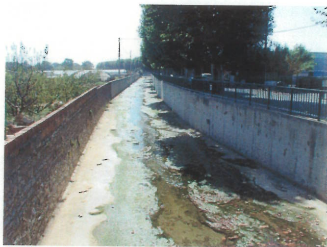
Roubaud : vue vers l'aval au niveau du gymnase municipal
