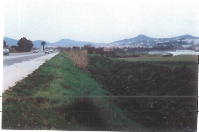
Amont de la nouvelle RN 98
