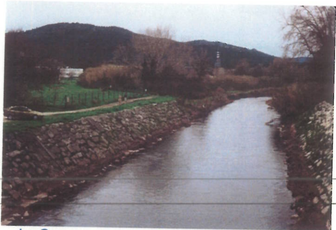
Le Gapeau, vue vers l'amont depuis le pont de l'ancienne RN 98
