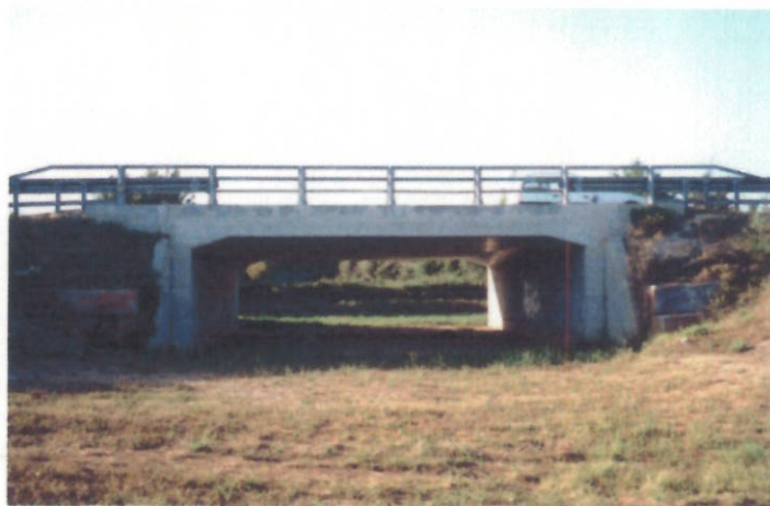
Ouvrage de décharge sous la Voie Olbia
