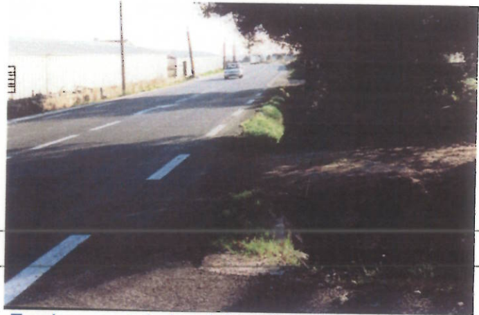
Emplacement du fossé à aménager en bord de RD 559
