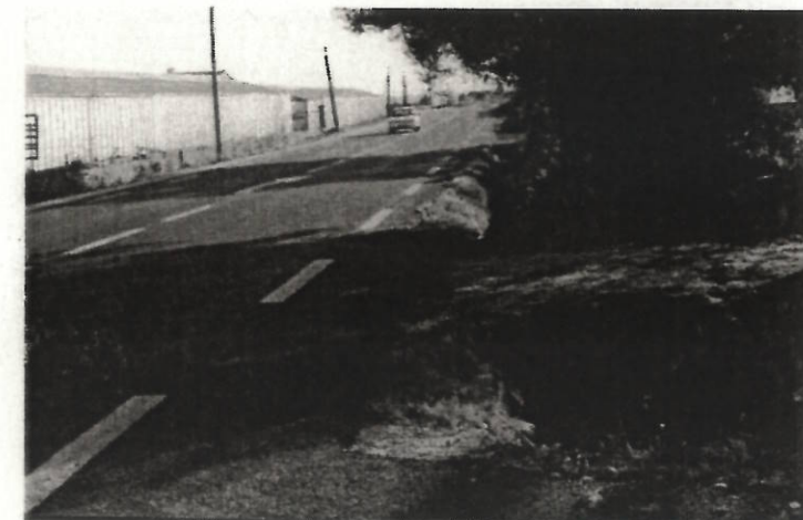
Emplacement du fossé à aménager en bord de RD 559
