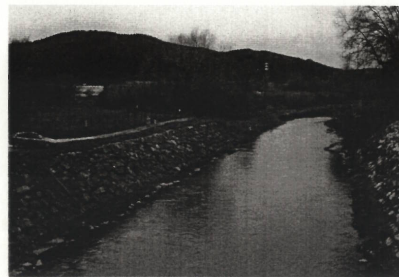
Le Gapeau, vue vers l'amont depuis le pont de l'ancienne RN 98
