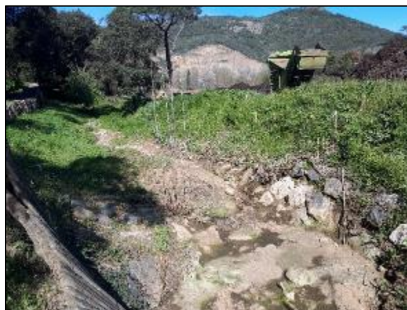
Exhaussement du fond du lit en aval du 1 er passage busé
