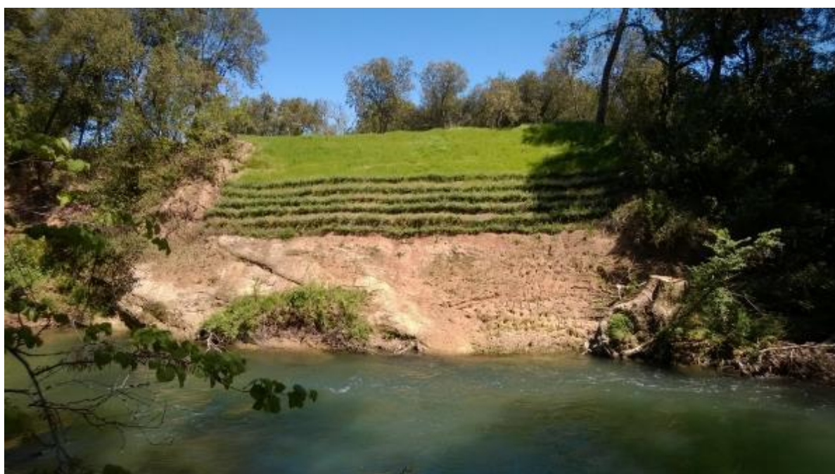
Figure 9: Exemple d'aménagement en lits de plants et plançons sur la commune de Vidauban (Argens sur le domaine du Château d'Astros)
