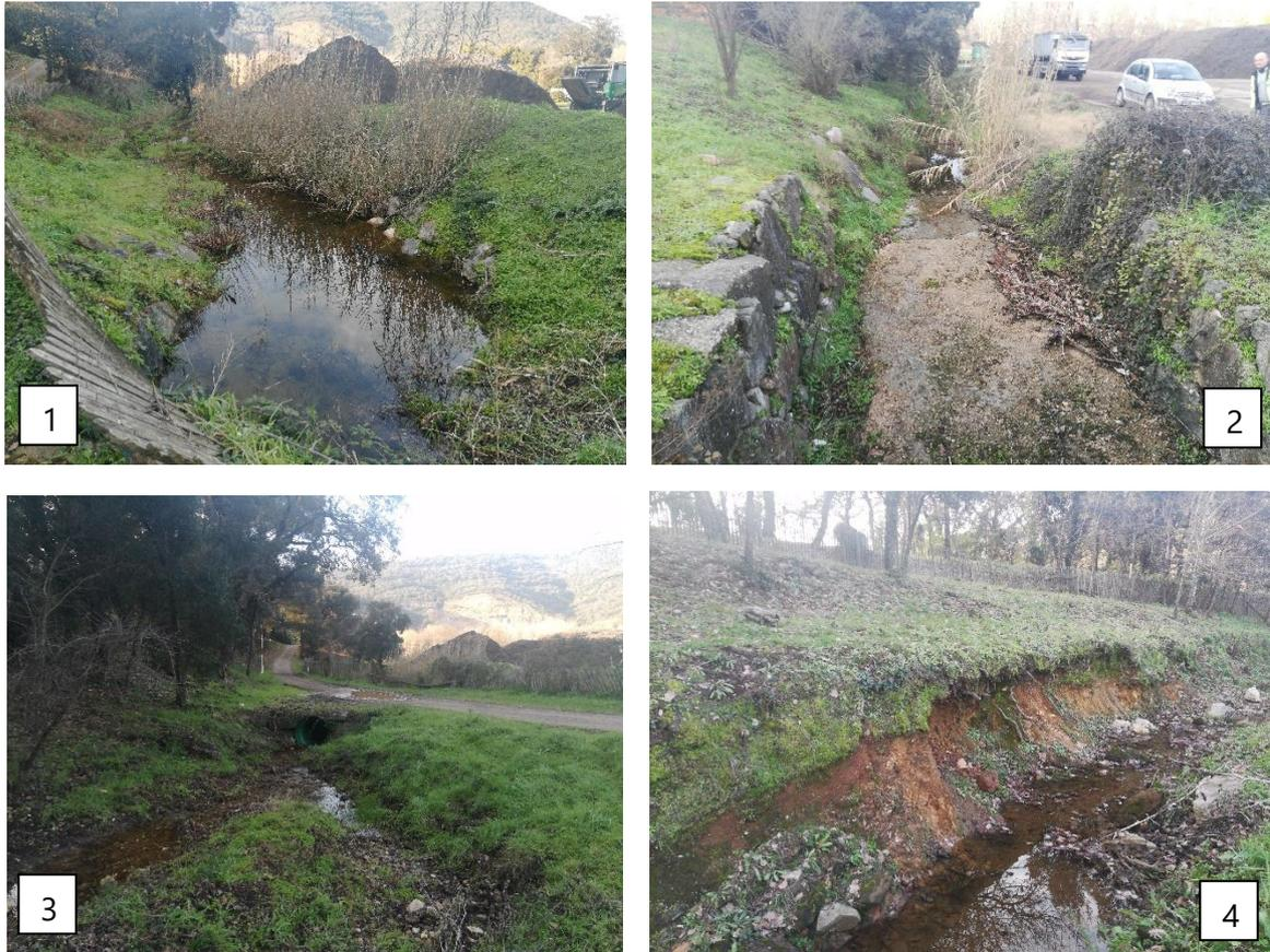
Figure 5: Exemples de désordres observés (1-Enrochements présents et canne de Provence, 2-Enrochements et radier béton, 3-Ouvrage hydraulique transversal, 4-Zone d'érosion de berge)
