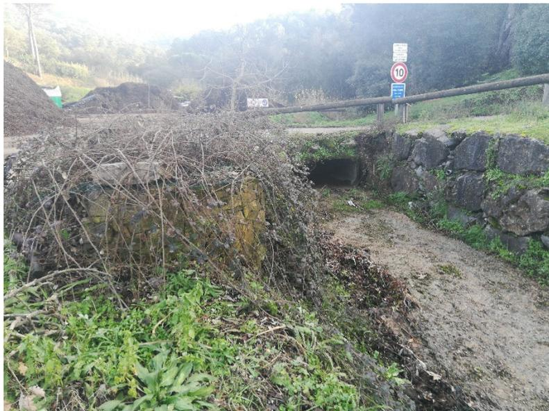
Figure 25 : Ouvrage intermédiaire (cadre béton) à supprimer
