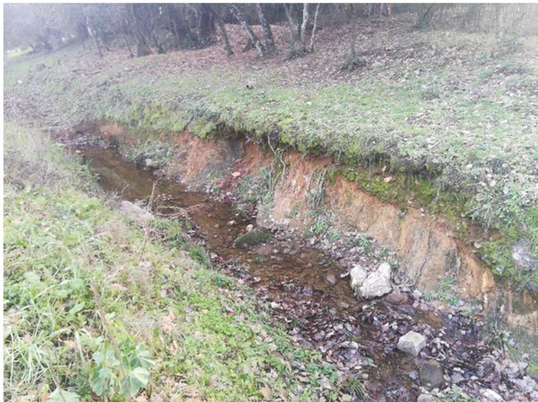
Figure 30 : Lentille d'érosion en RG à conforter
