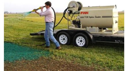
Deux passes seront réalisées pour l'ensemencement hydraulique : une première avant la mise en place de la toile coco, ainsi qu'une deuxième suite à la mise en place de ce géotextile.
