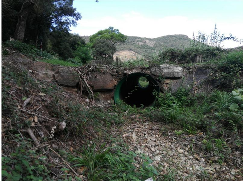
Figure 22 : Buse et enrochements à supprimer
