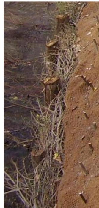
Figure 18: coupe type stabilisation pied de berge avec fascine inerte (exemple de photo à droite)
