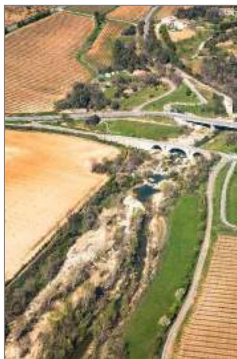
Figure 35 : Vue aérienne du site de la Pérussière avec le Pont Julien et la Via Domitia - PNRL, J. BRICHARD
