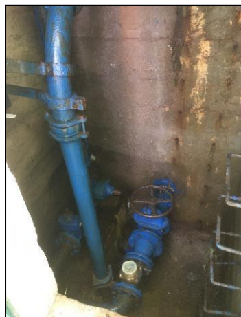
Photo 16 : Intérieur du réservoir de St Martin
