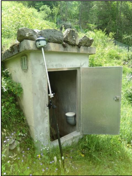
Photo 7 : Captage de Moullière
