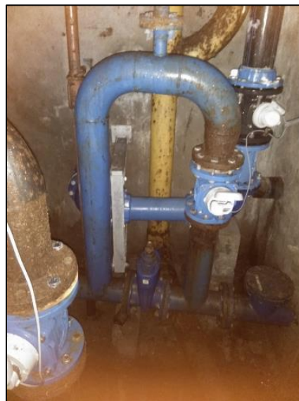
Photo 12 : Intérieur du réservoir de Prelles
