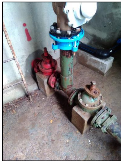
Photo 20: Intérieur du réservoir de Villard Meyer
