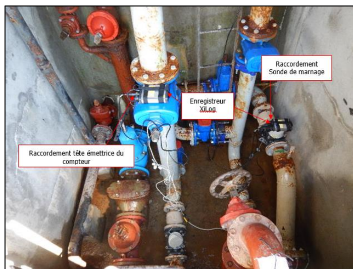
Figure 6 : Exemple de mise en place du matériel de mesure
