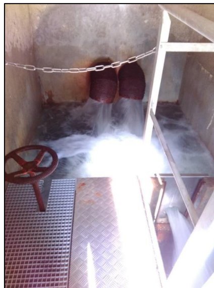
Photo 6 : Intérieur du captage du Sapet
