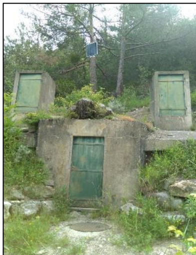
Photo 13: Réservoir de Ste Marguerite
