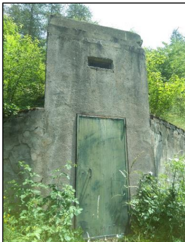
Photo 17: Réservoir de Queyrières
