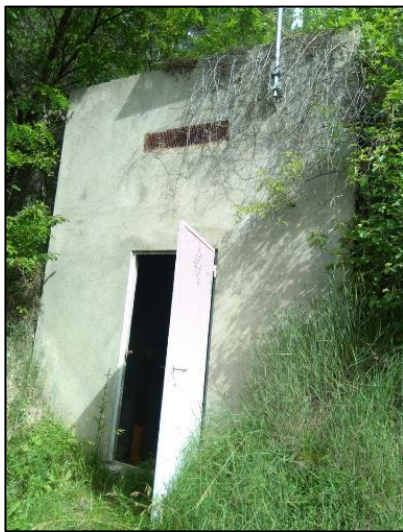
Photo 19: Réservoir de Villard Meyer
