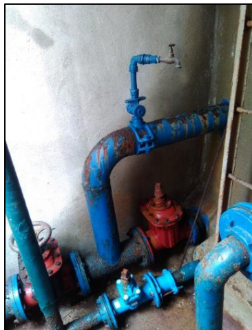
Photo 18 : Intérieur du réservoir de Queyrières
