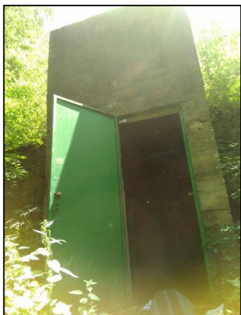
Photo 15: Réservoir de St Martin
