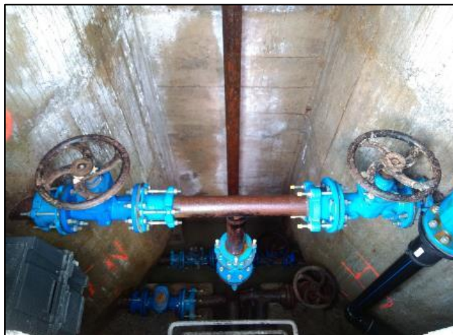
Photo 14 : Intérieur du réservoir de Ste Marguerite
