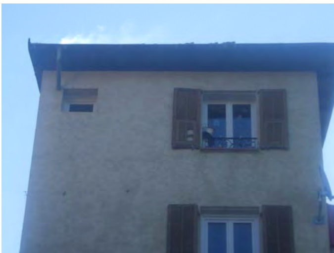
Illustration 12 : Tests à la fumée : Exemples de mauvais raccordements de gouttières
