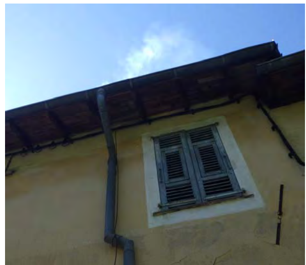
Illustration 12 : Tests à la fumée : Exemples de mauvais raccordements de gouttières
