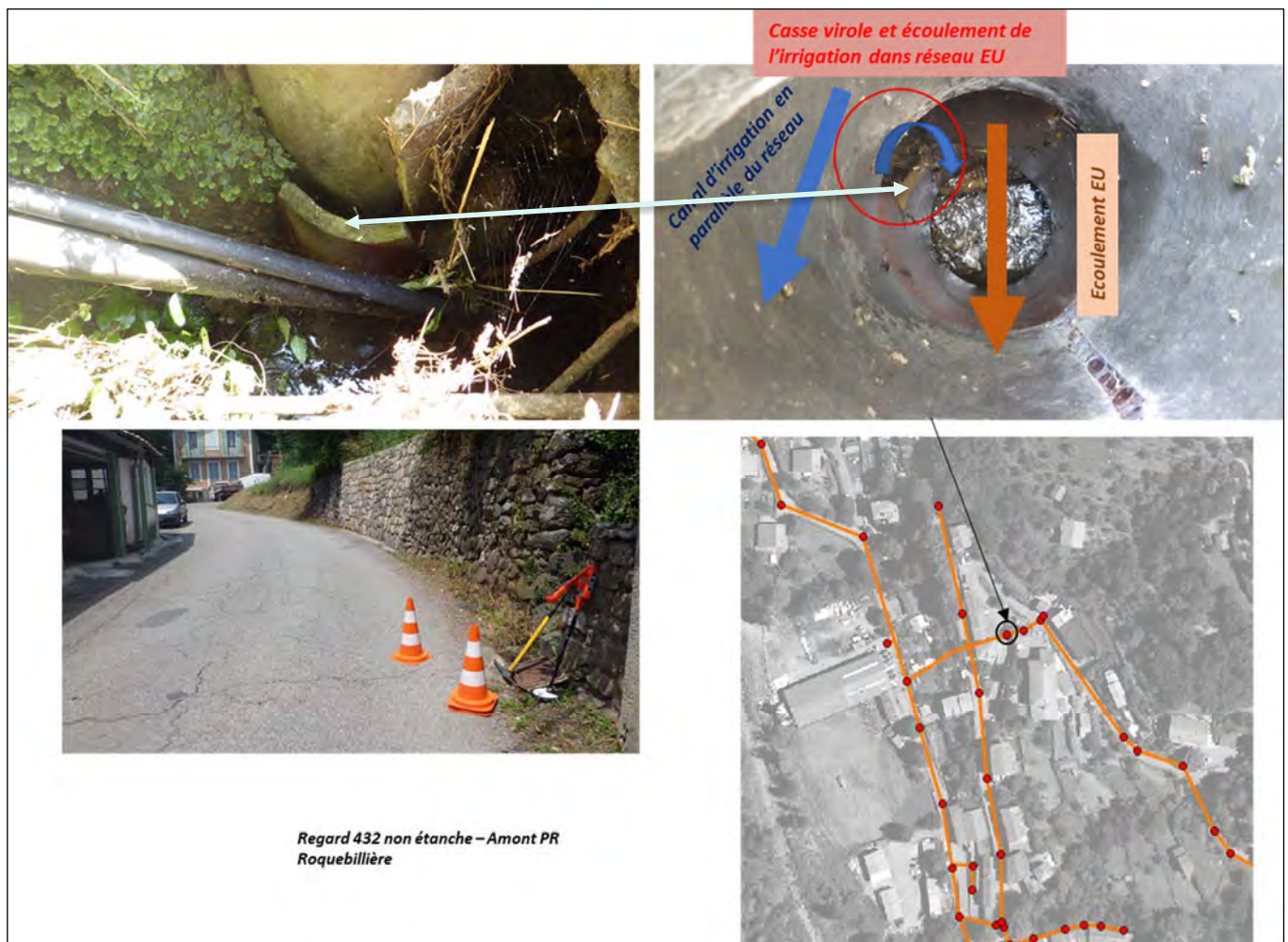
Illustration 5 : écoulement du canal d'irrigation dans Réseau EU - Amont PR Roquebillière
