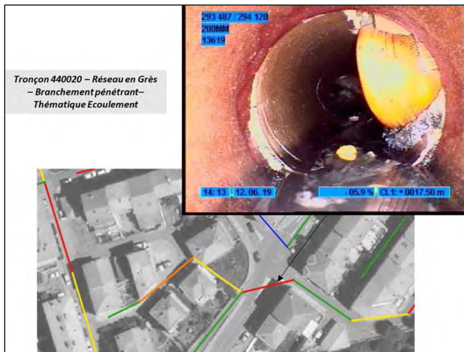
Illustration 28 : exemple anomalie Écoulement grave identifiée à l'ITV commune de Roquebillière – Branchement pénétrant
