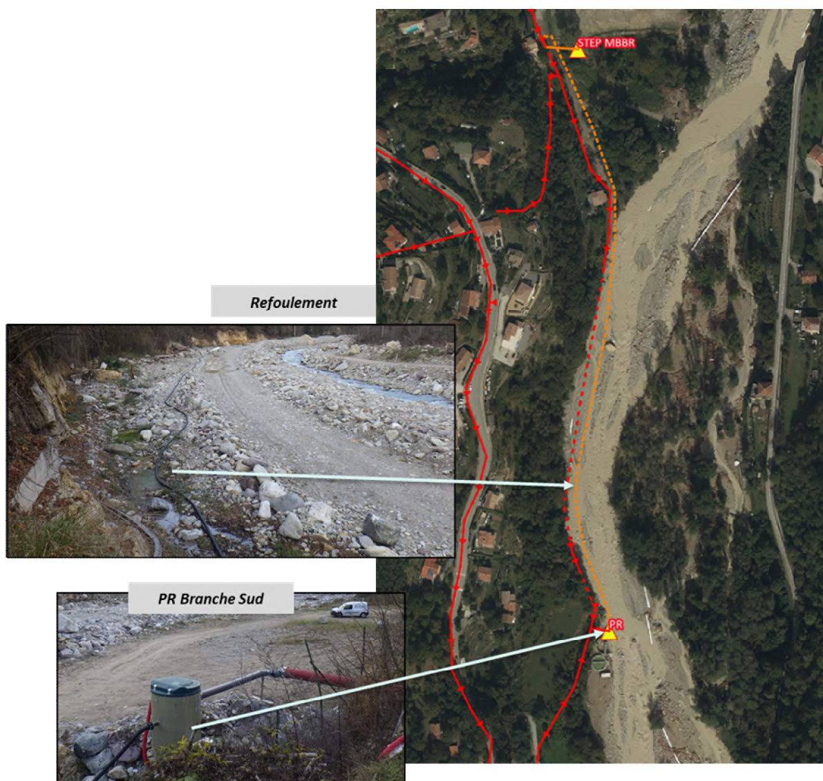
Illustration 23 : Travaux EU Post-Alex – secteur STEP Peira Grossa
