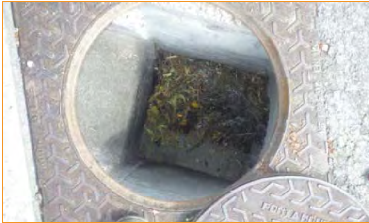
Illustration 5 : photographie d'un regard de collecte dont l'état structurel général a été jugé de "moyen"
