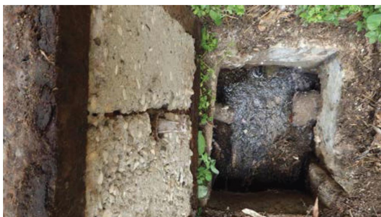
Illustration 34 : Exemple de présence grave de racines – Système du Zibac
