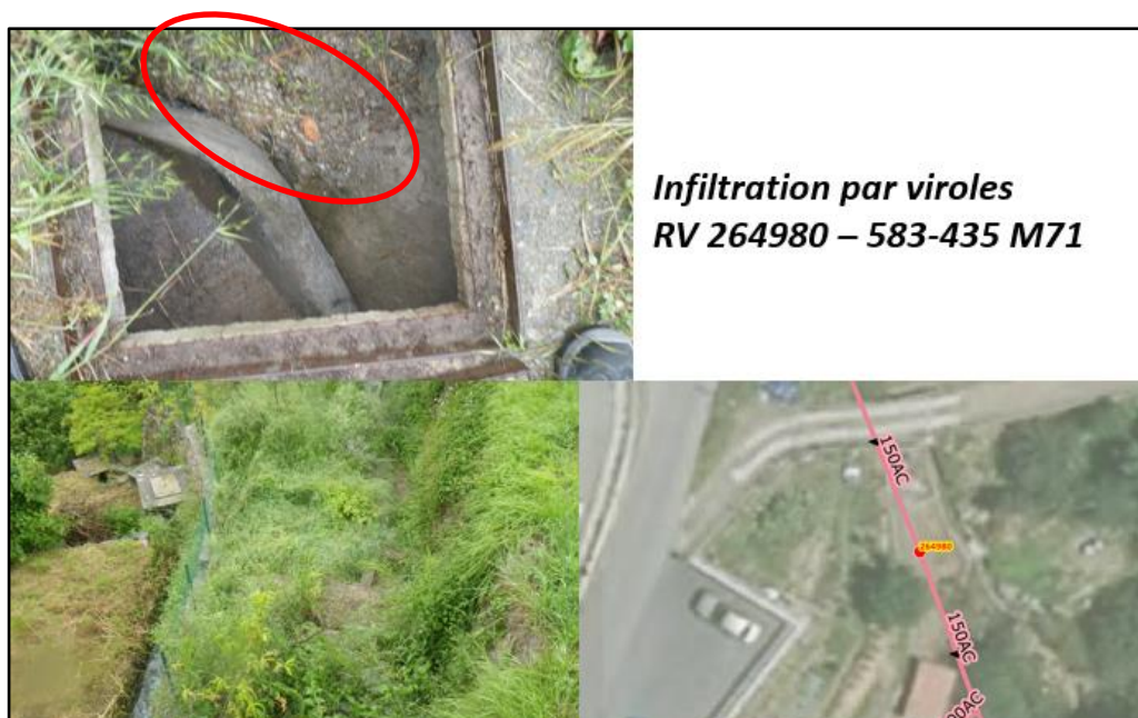
Illustration 16 : Exemple d'infiltration d'eaux claires parasites par viroles – Système du Boucart
