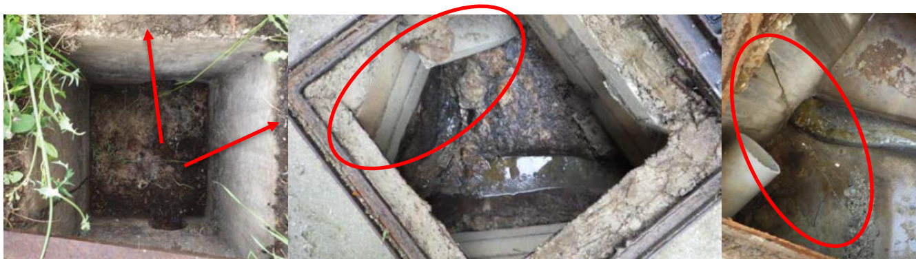
Illustration 32 : Exemples de couronne, virole et banquette défectueuses très graves – Système du Zibac
