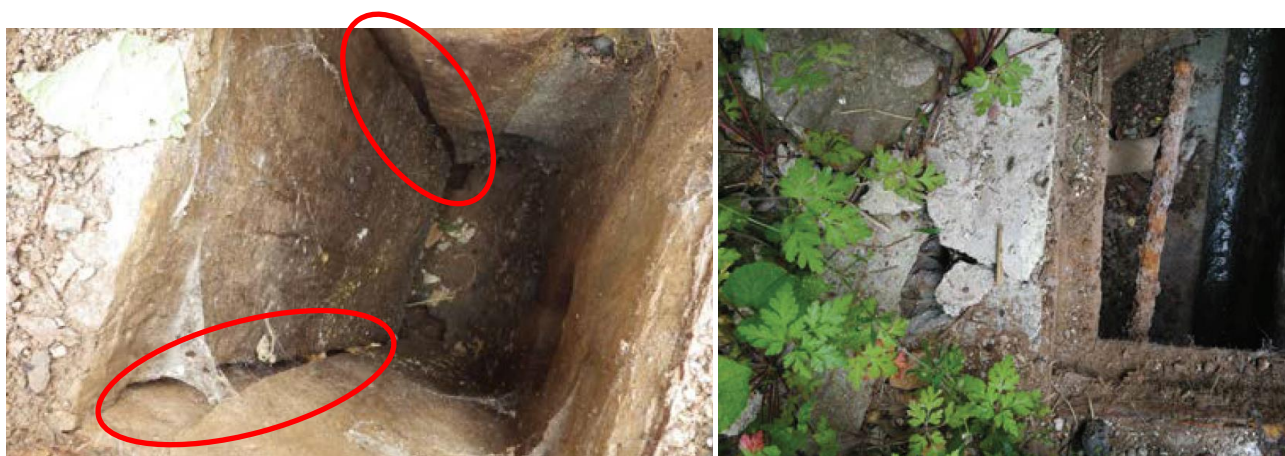
Illustration 13 : Exemples de viroles et couronnes défectueuses - Système du Boucart
