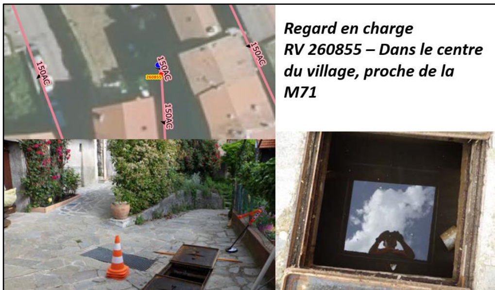
Illustration 27 : Exemple de regard en charge très grave – Système du Zibac
