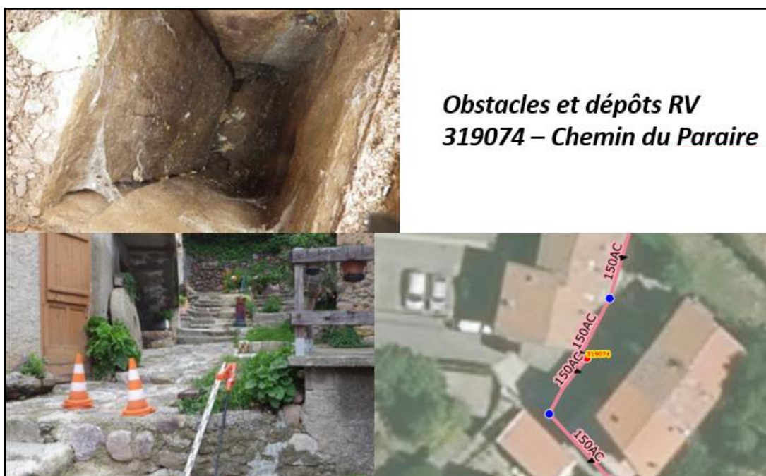
Illustration 9 : Exemples d'obstacles et dépôts – Système du Boucart
