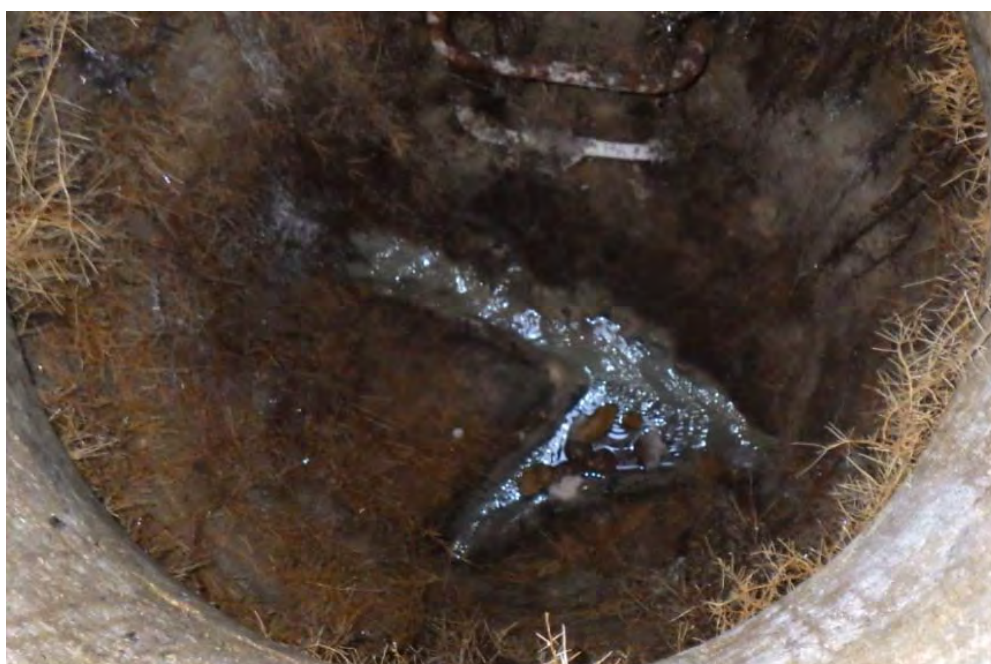
Figure 16 : Regard n°58455 – Rue des Maures
