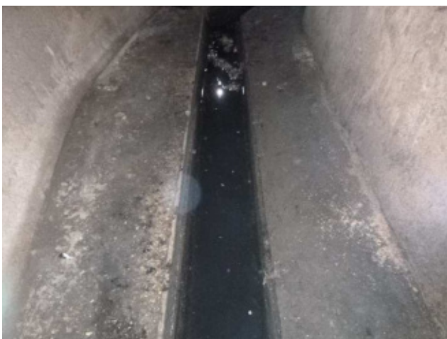
PM0-PM6 vue radier – 2 banquettes et 1 cunette
