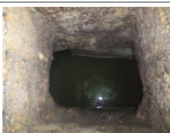
Regard d'accès aux Sorguettes – Rue Guillaume Puy
