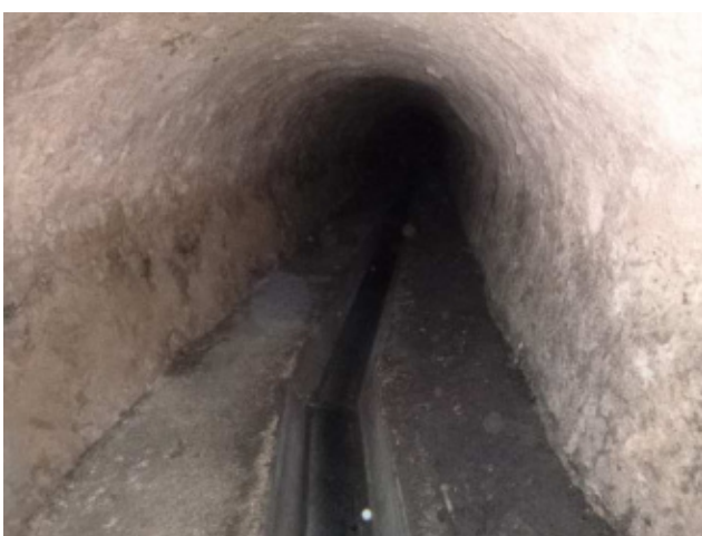
Changement de section 1600– vue générale
