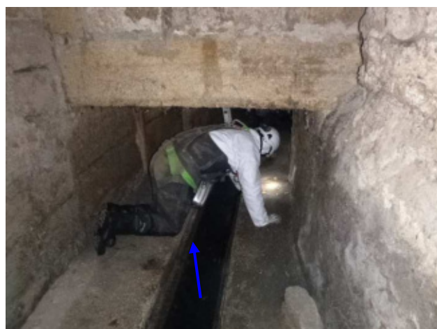
Vue sens écoulement (vers R1) PM5 (Section 0.8x1.5m)
