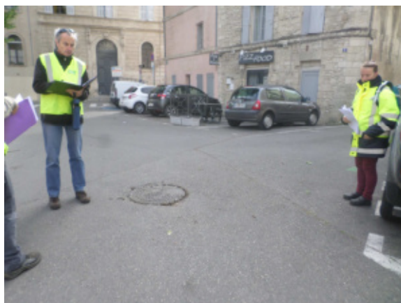
Déversoir d'orage du collecteur K vers les Sorguettes – Place Saint Joseph
