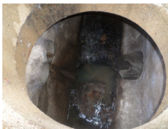
Regard d'accès aux Sorguettes – Busage en Ø1000
