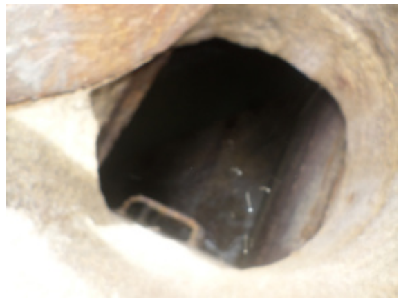
Regard d'accès aux Sorguettes
