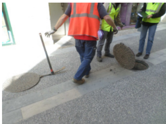
Regard d'accès aux Sorguettes
