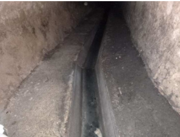
Changement de section 1600– vue générale
