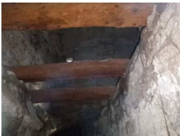
Poutre de remplacement en voute
