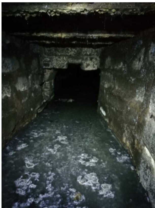
rue Joseph Vernet vers ouest (photo Véolia)
