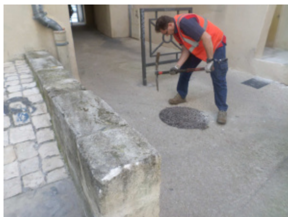
Regard d'accès aux Sorguettes
