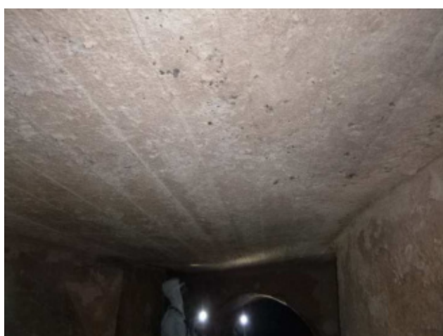
PM0-PM6 Dalle coffrée en voute – Bon état
