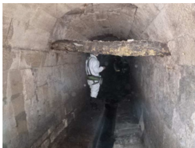
PM15 Galerie visitable 230/150cm – blocs de maçonnerie apparente
