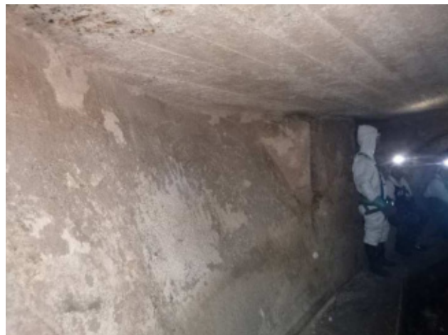
PM0-PM6 Dalle coffrée en voute – Bon état
