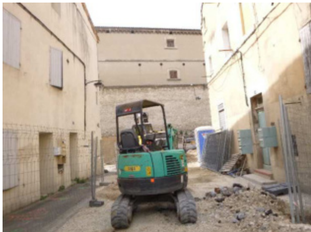
Vue en surface depuis regard vers chambre de visite en aval
