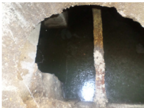
Regard d'accès aux Sorguettes
