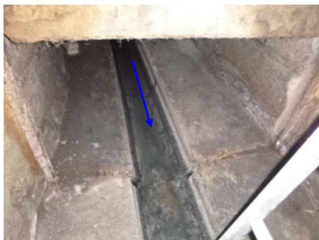
Vue amont du regard – vers Canal de la Pépinière
