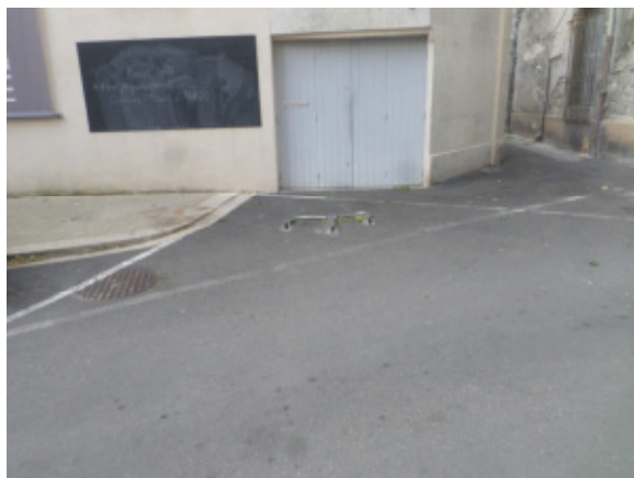
Regard de visite sur réseau EU se rejetant directement aux Sorguettes – Rue des 3 Pilats
