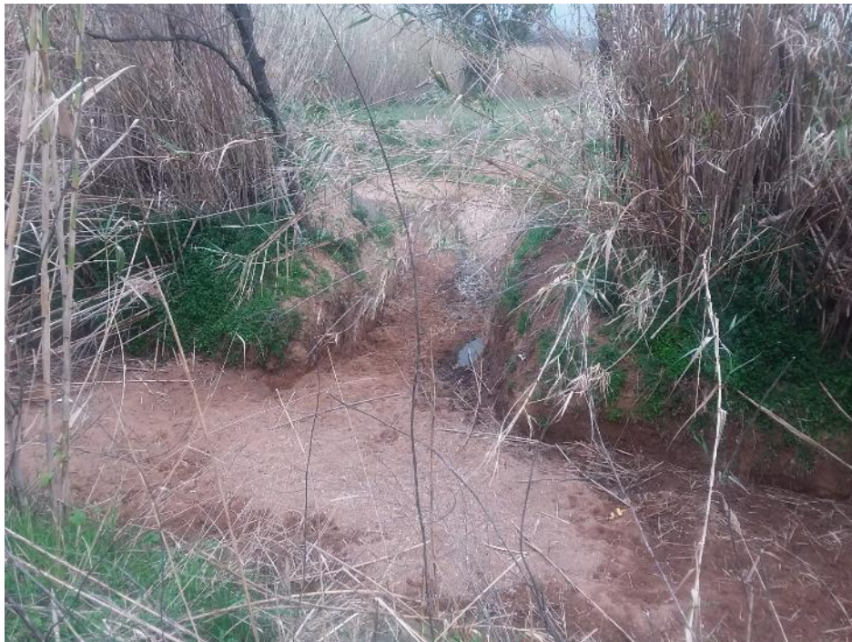
FIGURE 16 - OBSTRUCTION DU CANAL DE CEINTURE PAR TRANSPORT SOLIDE
