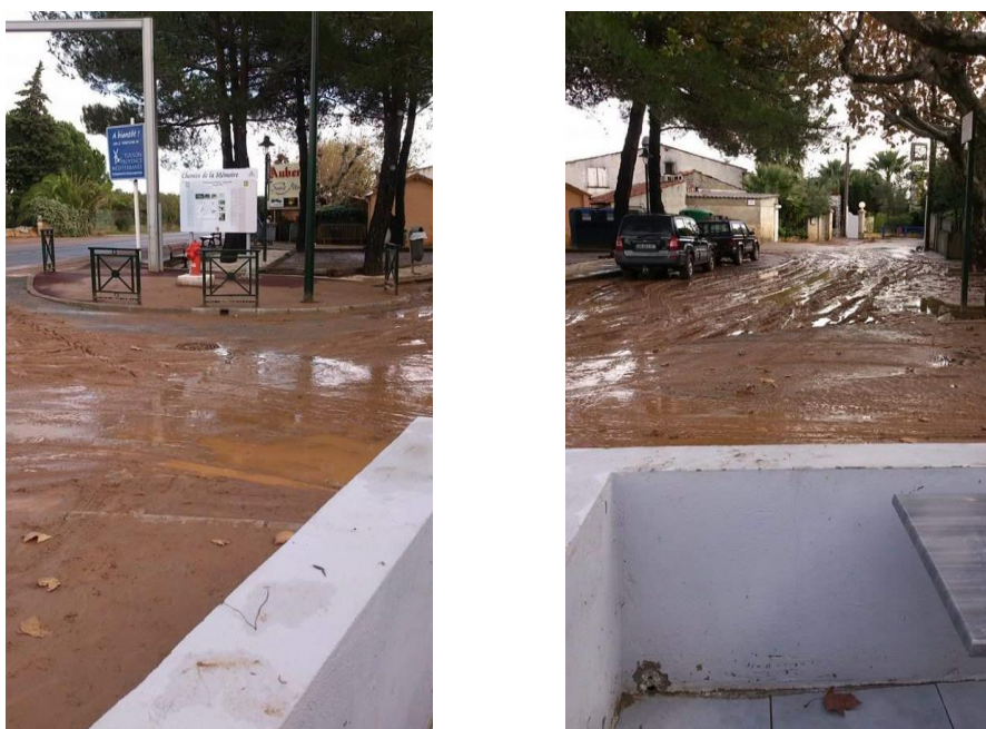
FIGURE 102 - PHOTOS DE TEMOINS REALISEES LE LENDEMAIN DE L'EPISODE PLUVIEUX DU 19 JANVIER 2014
