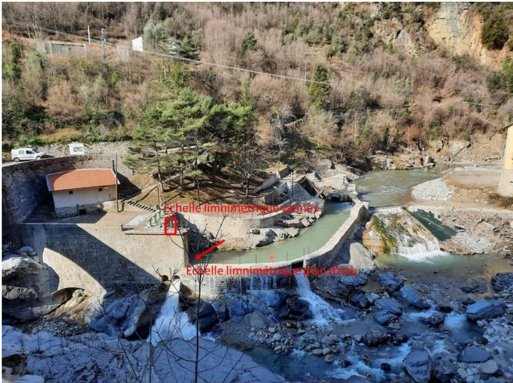
Figure 23 : Vue des échelles limnimétriques à la prise d'eau
