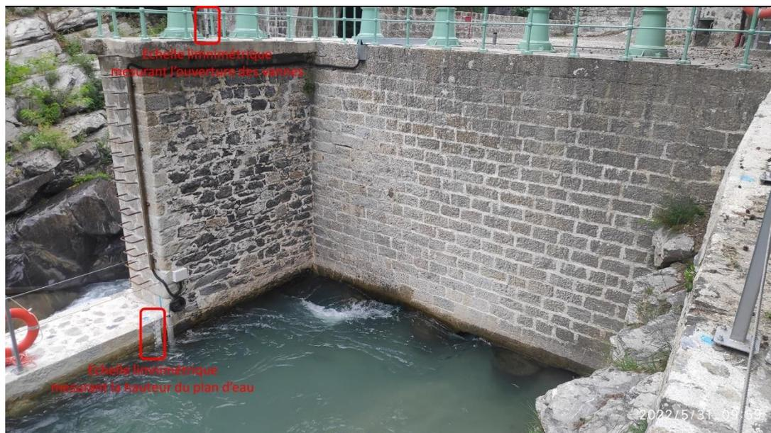
Figure 22 : Echelles limnimétriques à la prise d'eau
