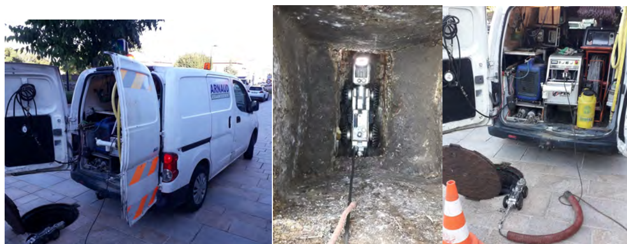
FIGURE 4 : Réalisation des tests à la fumée (Source : Arnaud Assainissement)
