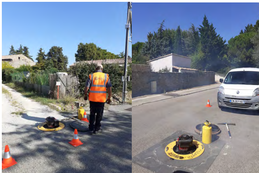
Figure 1 : Réalisation des tests à la fumée (Source : Egis)
