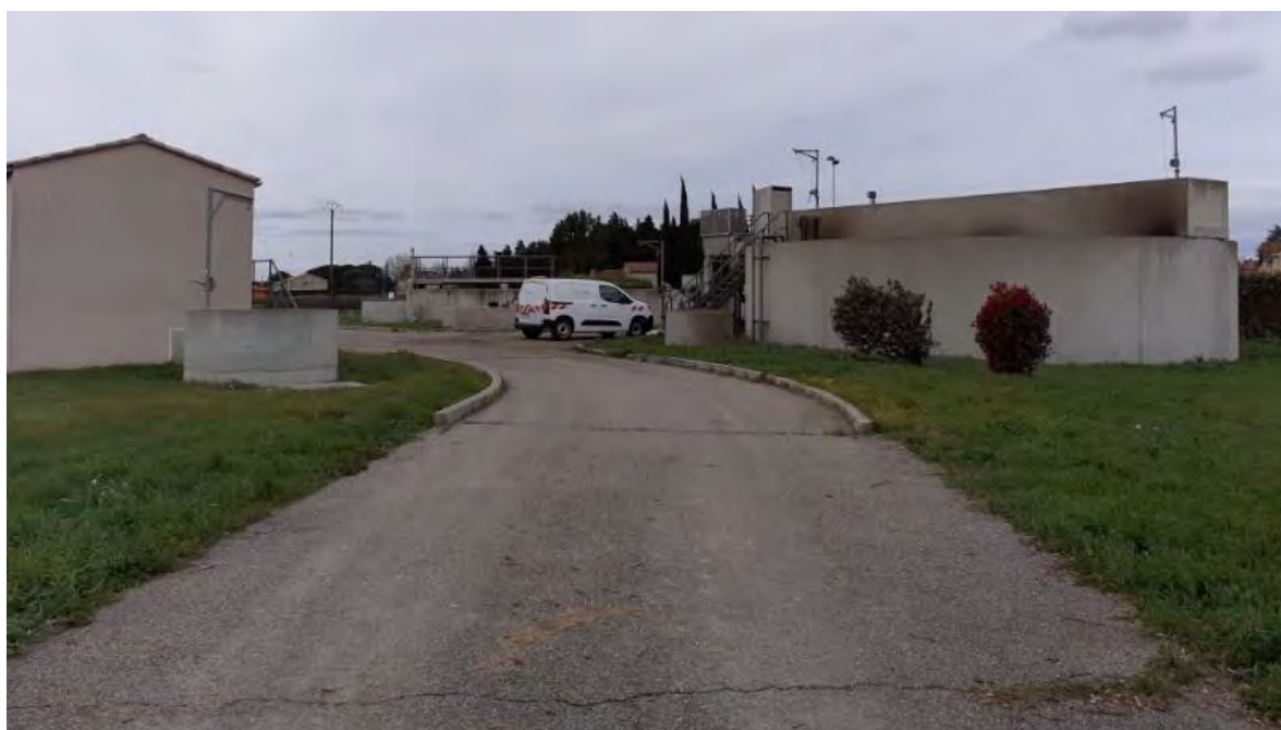
FIGURE 12 : Entrée STEP Violès (Source : EGIS)
