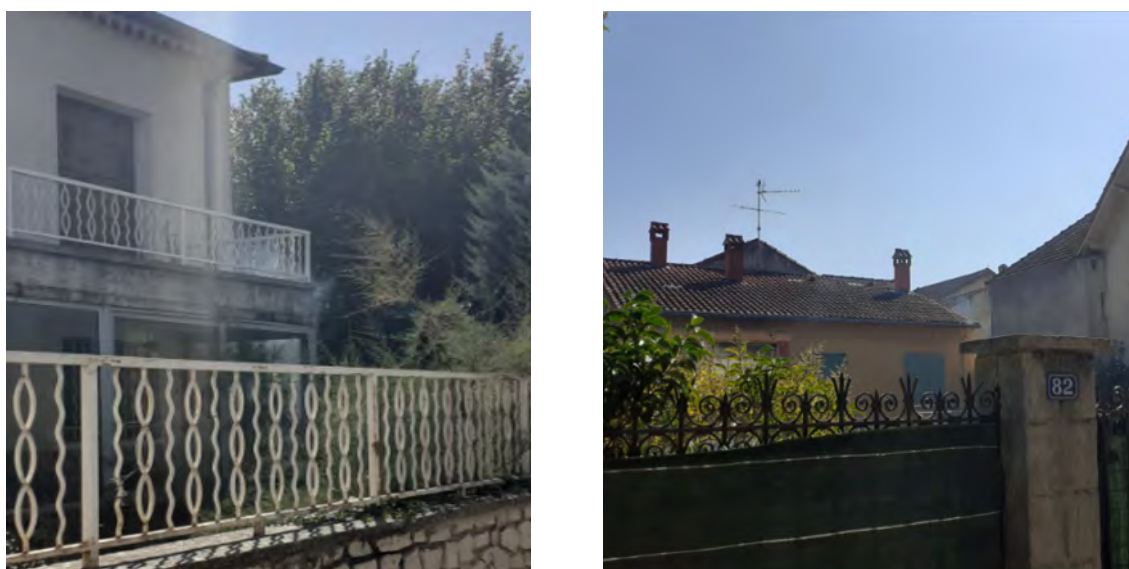
Figure 2 : Gouttières raccordées au réseau EU (Source : Egis)
