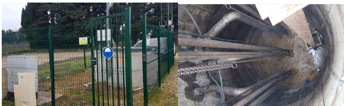
FIGURE 18 : Report photos PR ancienne STEP (Source : EGIS)
