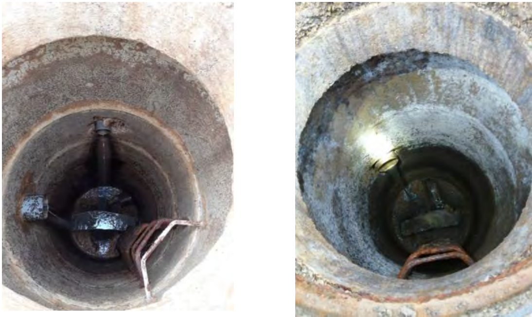
FIGURE 16 : Branchement pénétrant (Source : EGIS)
