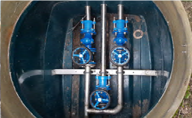
Chambre de vannes
