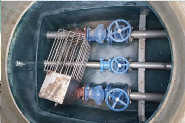
Chambre de vannes
