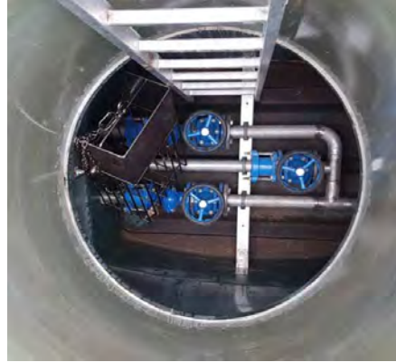
Chambre de vannes
