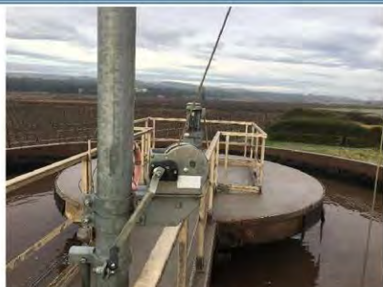
Bassin d'aération N°2
