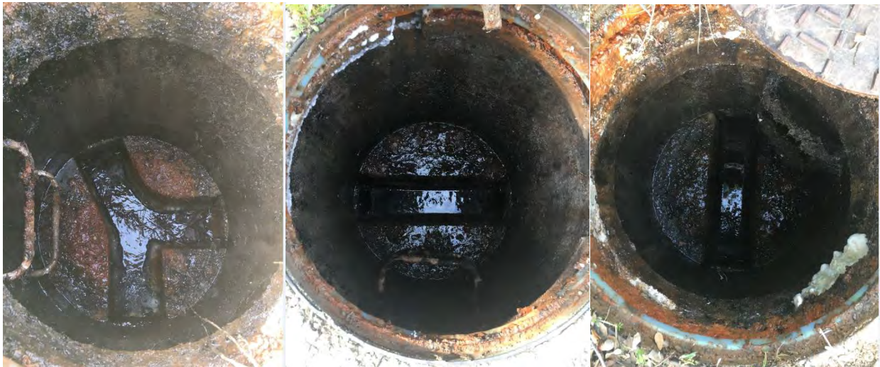
Figure 19 : Intérieur regard Chemin de Florette (Source : EGIS)
