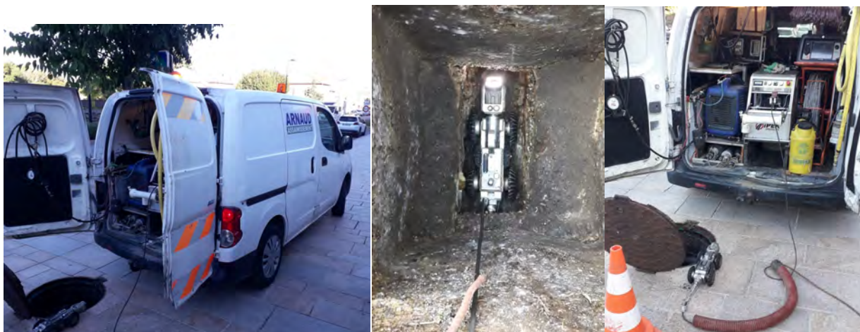
FIGURE 5 : Réalisation des tests à la fumée (Source : Arnaud Assainissement)
