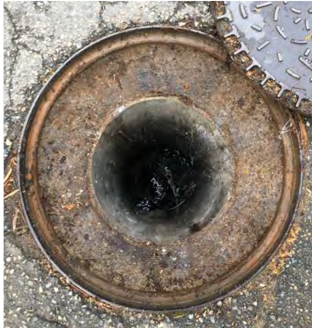
Figure 18 : Intérieur regard sainte Cecilia (Source : EGIS)
