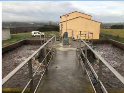
Bassin d'aération N°1
