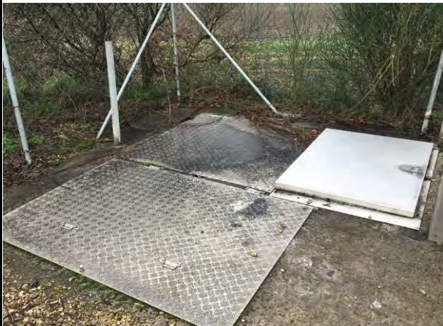
Extérieur chambre de vannes
