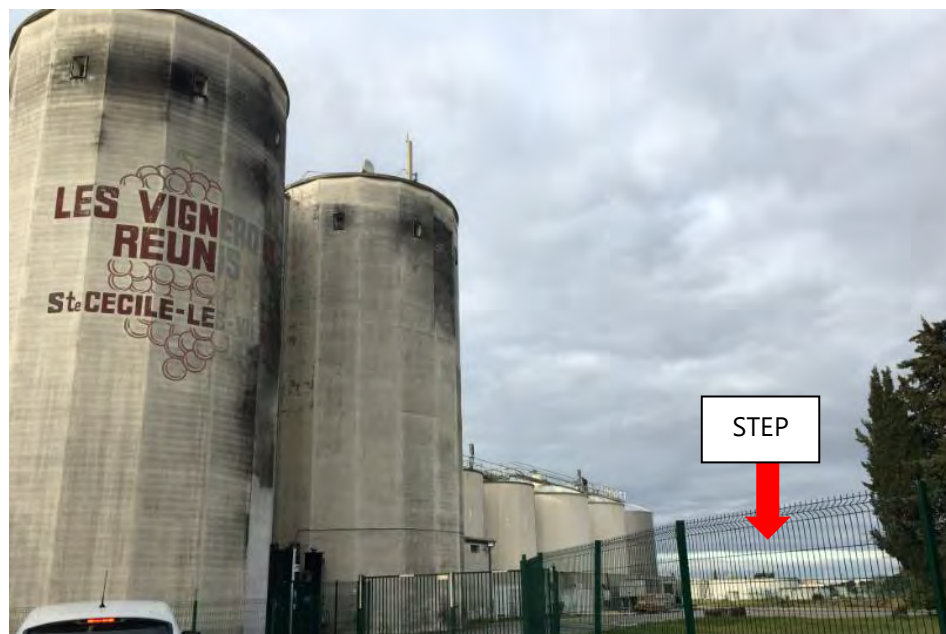
Figure 22 : STEP Coopérative Les Vignerons réunis (Source : EGIS)
