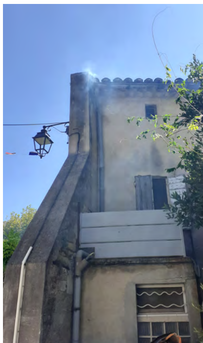
FIGURE 3 : Gouttière raccordée au réseau assainissement (Source : Egis)
