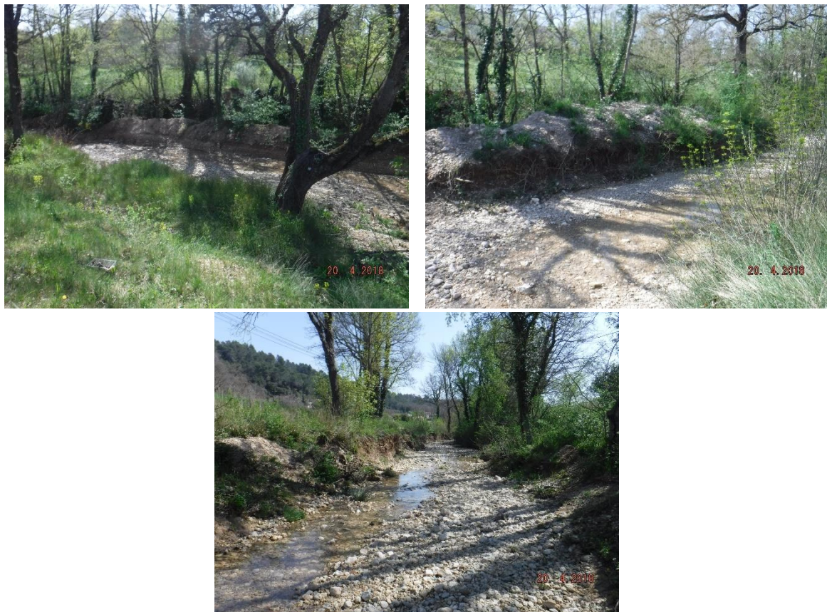
Figure 19 - Illustrations photographiques de curage et/ou recalibrage de cours d'eau
