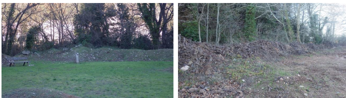
Figure 17 – Illustration de remblais sauvages observés sur le bassin versant du Gapeau (à gauche au niveau du terrain de sport du lieu-dit Les Papeteries à Solliès-Pont/ à droite en rive droite du Merlançon au niveau du lieu-dit La Guirane)
