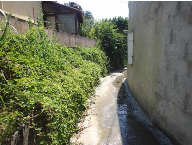
Figure 7 : secteur entièrement clos sur le Mal Vallon
