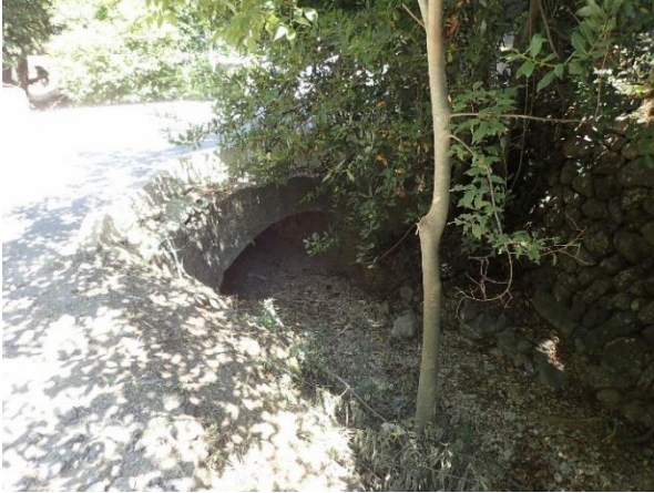
Figure 3 : arbre spontané poussant devant un ouvrage (Ripelle)
