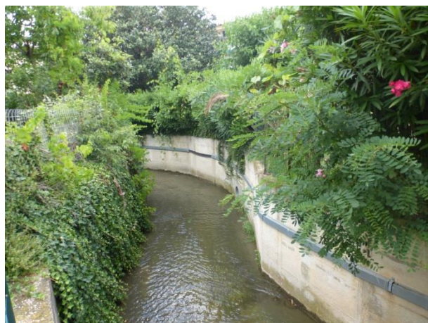
Figure 1 : le Pontillot, bétonné dans la traversée de Six-Fours-les-Plages
