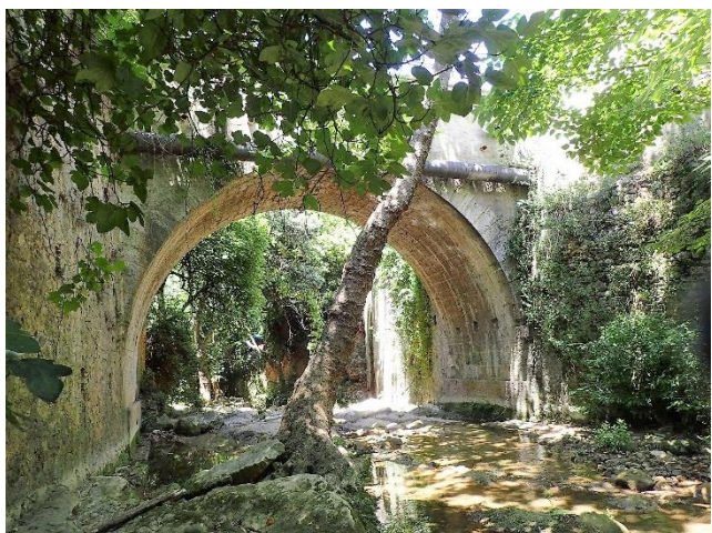
Figure 52 : platane en amont du pont de l'Ubac (Las)
