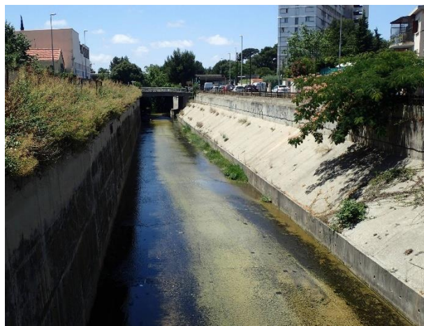
Figure 2 : le lit artificiel du Las dit la "rivière Neuve" et construit dans les années 70 et 80
