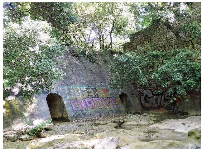
Figure 10 : vue aval du barrage des 3 martelières sur le Las
