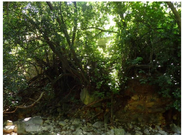
Figure 39 : construction sur une berge semblant instable (Las)
