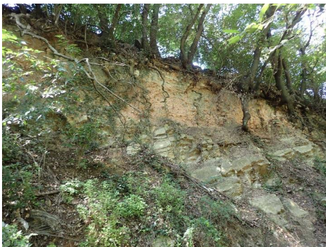
Figure 40 : falaise instable le long d'un propriété (Ripelle)
