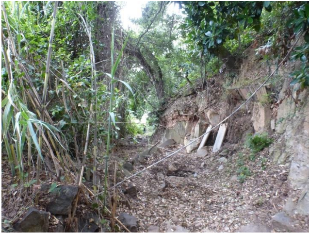
Figure 44 : berge érodée menaçant une propriété (Oursinières)
