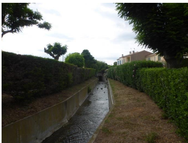
Figure 19 : entretien drastique et nécessaire des abords du lit bétonné (Pontillot)
