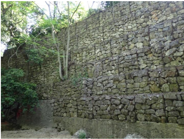
Figure 15 : ouvrage de soutènement de la route réalisé en gabions et en train de se boiser (aval barrage des 3 martelières)
