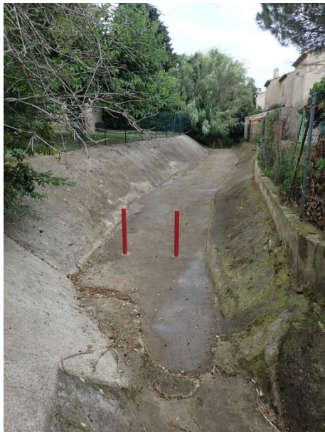
Figure 17 : tri bois sur Fontvielle en amont d'un passage couvert à Six-Fours-les-Plages
