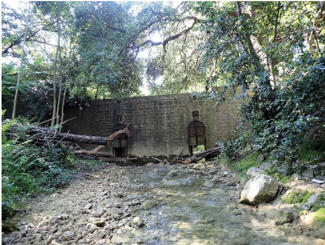
Figure 9 : vue amont du barrage des 3 martelières sur le Las
