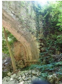
Figure 14 : dégradation en rive droite de la maçonnerie du barrage des 3 martelières
