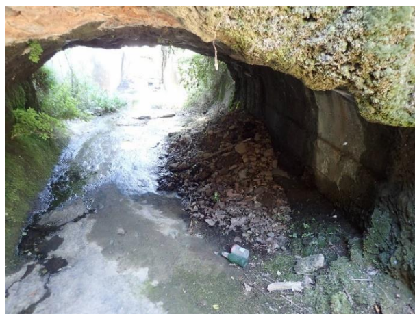
Figure 37 : petit dépôt au niveau d'un ouvrage (Real Baye)
