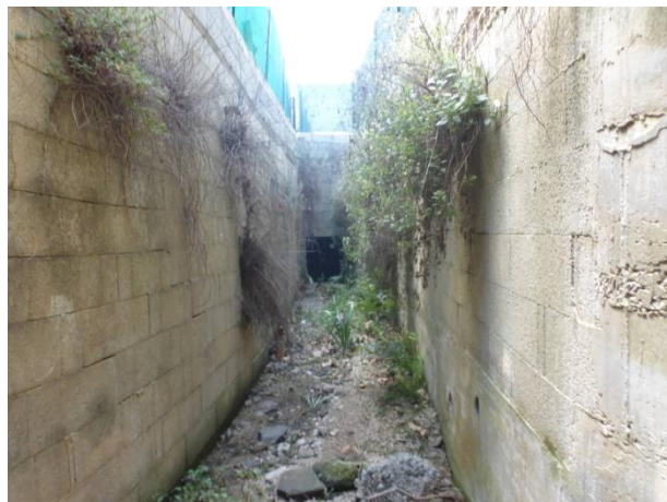
Figure 38 : dépôt sédimentaire à l'amont d'un ouvrage (Augias)
