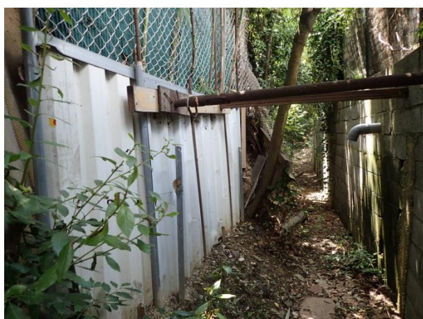
Figure 48 : ouvrage rustique sur le Bouchou réalisé pour consolider la berge – risque d'embâcle important
