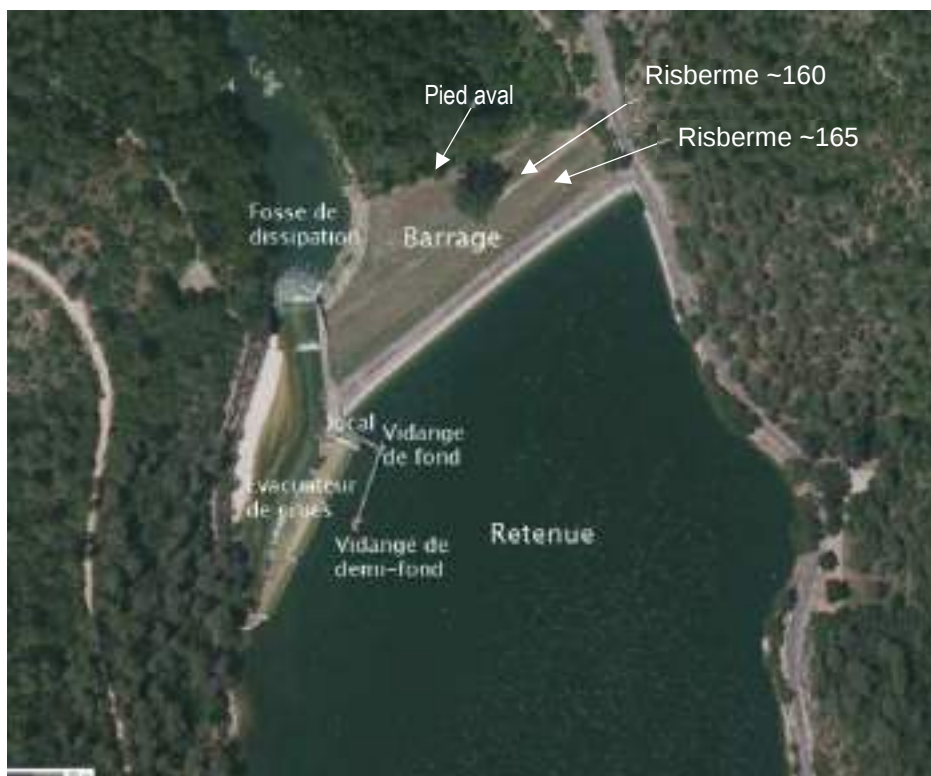
Figure 4. Vue générale du barrage
