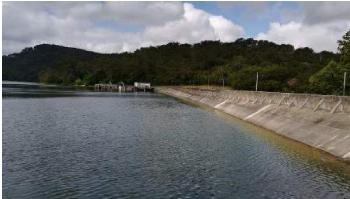
Figure 1 : Vue de l'ouvrage de Carcès
