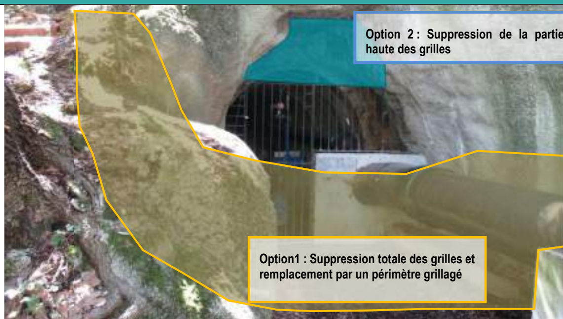
Figure 31. Adaptation ou suppression des grilles au profit d'un périmètre grillagé afin de favoriser le passage des chiroptères
