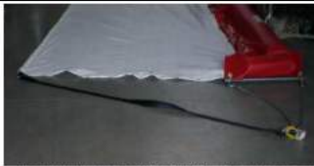
Barrage flottant avec jupe de filtration MES dépliée pour travaux sur cours d'eau
