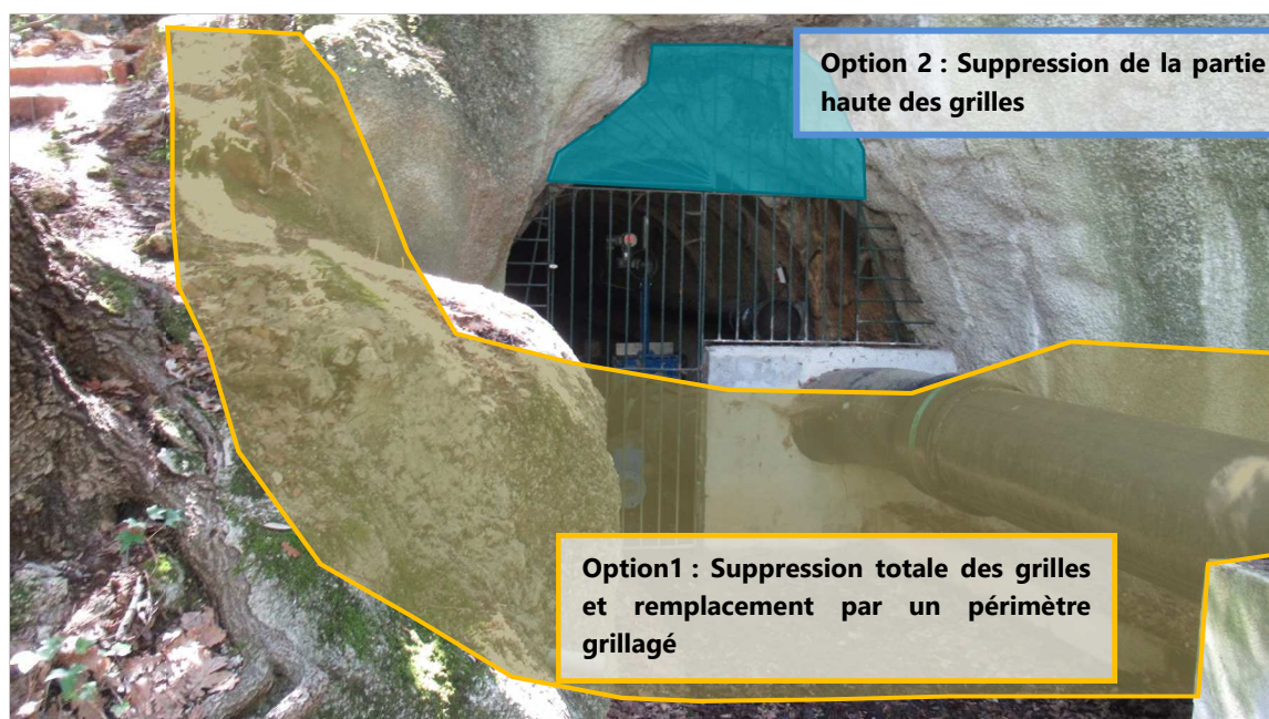
Figure 2. Adaptation ou suppression des grilles au profit d'un périmètre grillagé afin de favoriser le passage des chiroptères
