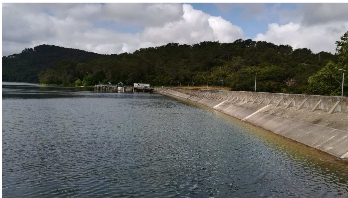
Figure 1 : Vue de l'ouvrage de Carcès
