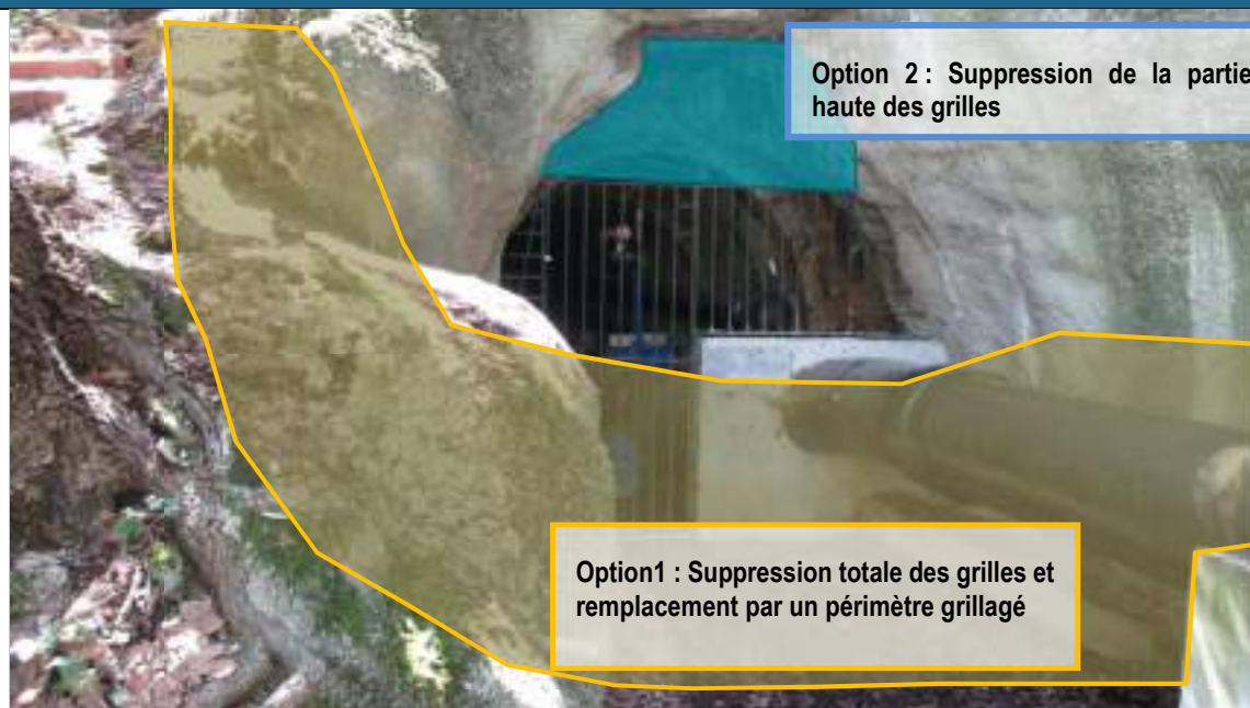
Figure 18. Adaptation ou suppression des grilles au profit d'un périmètre grillagé afin de favoriser le passage des chiroptères
