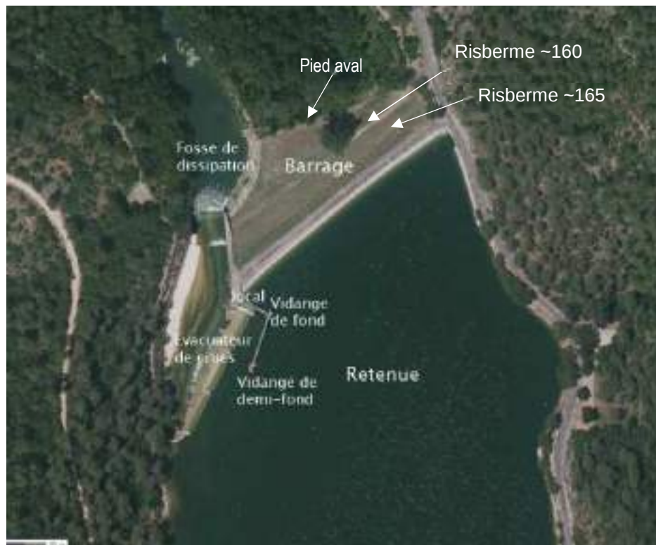
Figure 2. Vue générale du barrage
