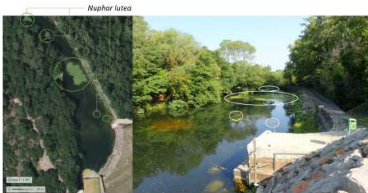
Figure 29 : Situation de Nuphar lutea dans la fosse de dissipation
