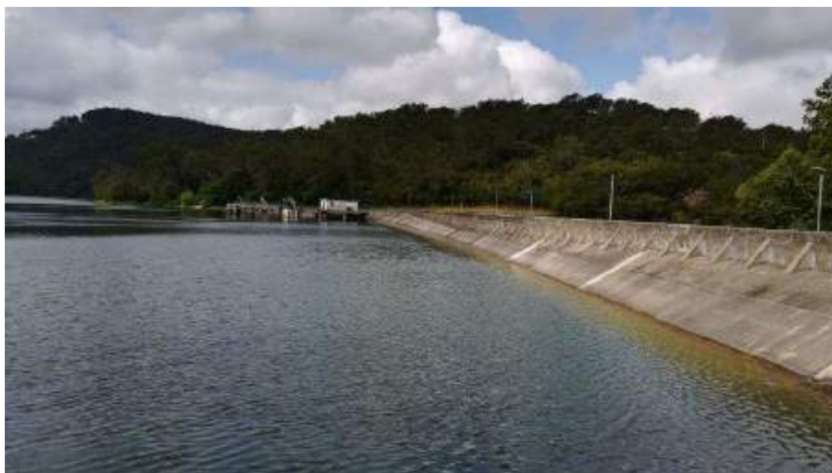
Figure 94 : Vue de l'ouvrage de Carcès
