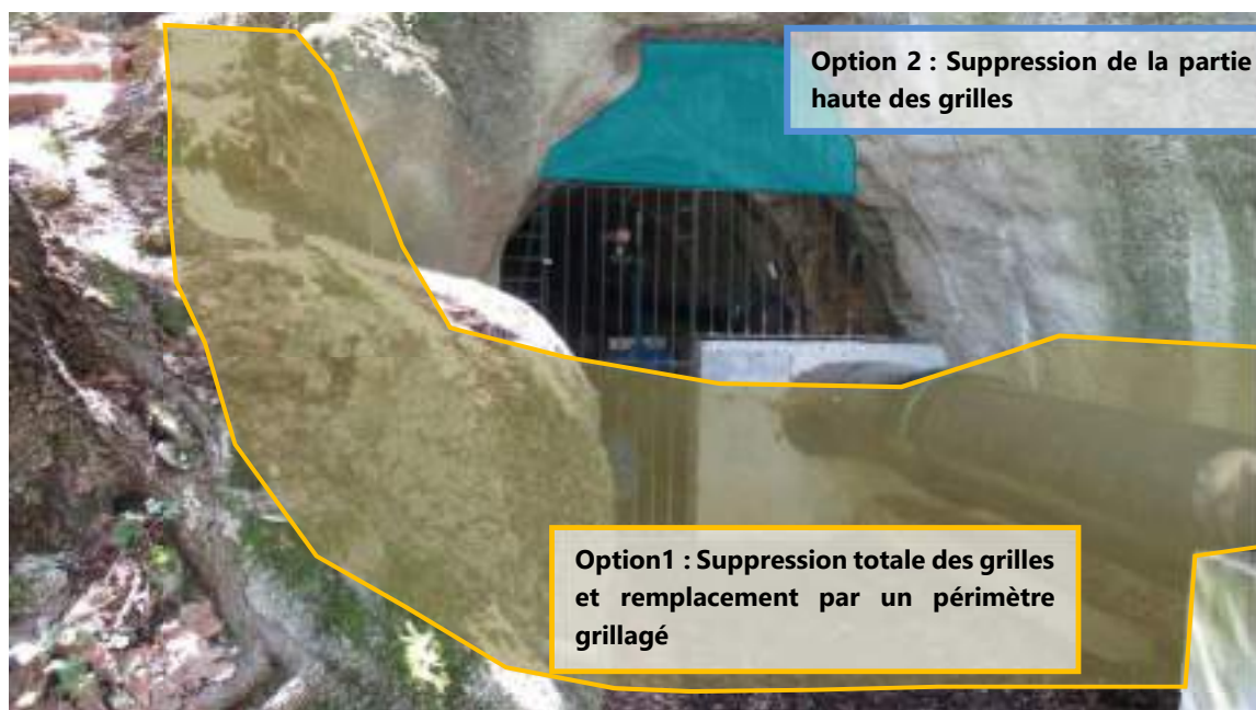
Figure 87. Adaptation ou suppression des grilles au profit d'un périmètre grillagé afin de favoriser le passage des chiroptères
