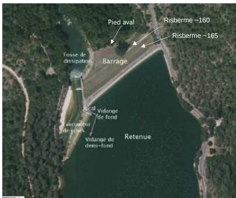
Figure 4 : Vue générale du barrage
