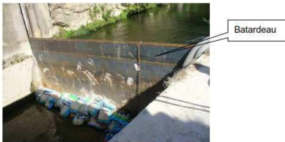
Figure 12 : Batardeau aval mis en place lors de la dernière inspection à sec en 2008
