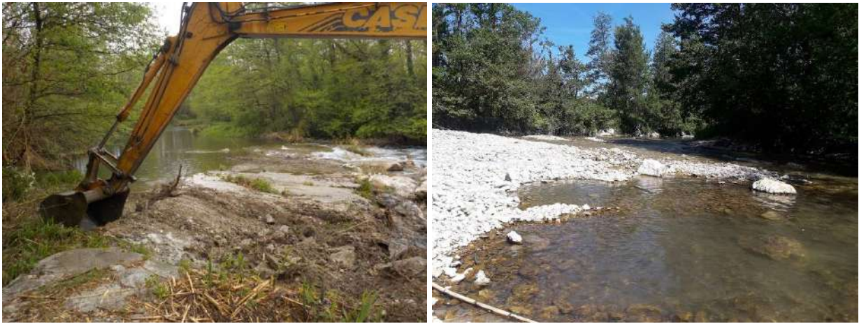
Photo du seuil pendant et après travaux.
