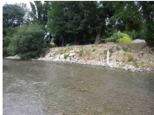
Protection de berge artisanale en rive gauche
