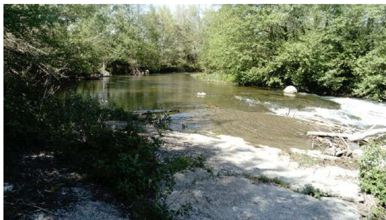
Photo du seuil ROE 34885 pris depuis la rive gauche au niveau du seuil/ Date : 19/04/18
