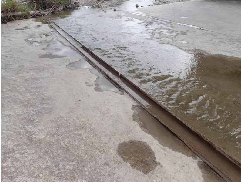
Figure 15 : Rails de ferrailage de la croute béton
