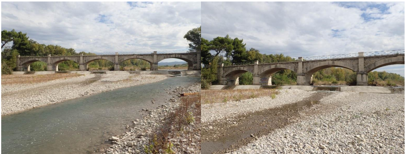
Figure 3 : Photographie du seuil de la RD 20 en octobre 2018 Source : GRAINEau/SIGosphère
