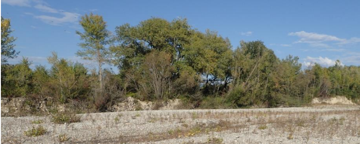
Photos de la berge droite à 400 ml en amont du pont
