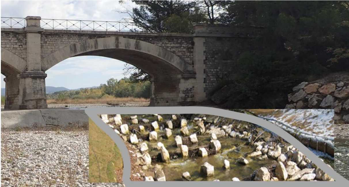
Photo montage de la rampe en aval de l'arche de gauche du RD 20
