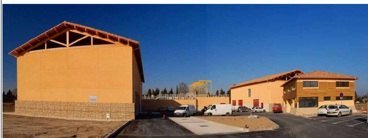
Vue extérieure de la station
