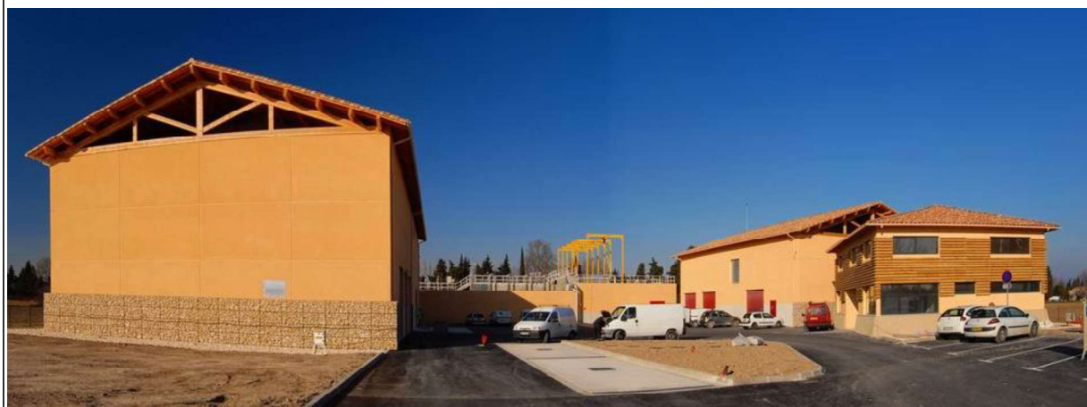
Vue extérieure de la station
