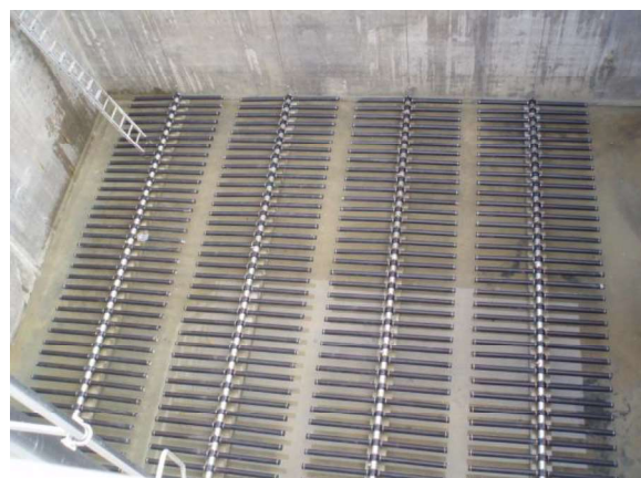
Vue bassin d'aération (vidé)
