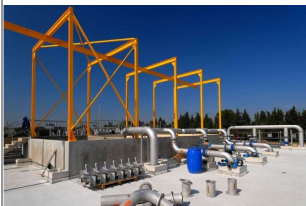
Vue portique membranes
